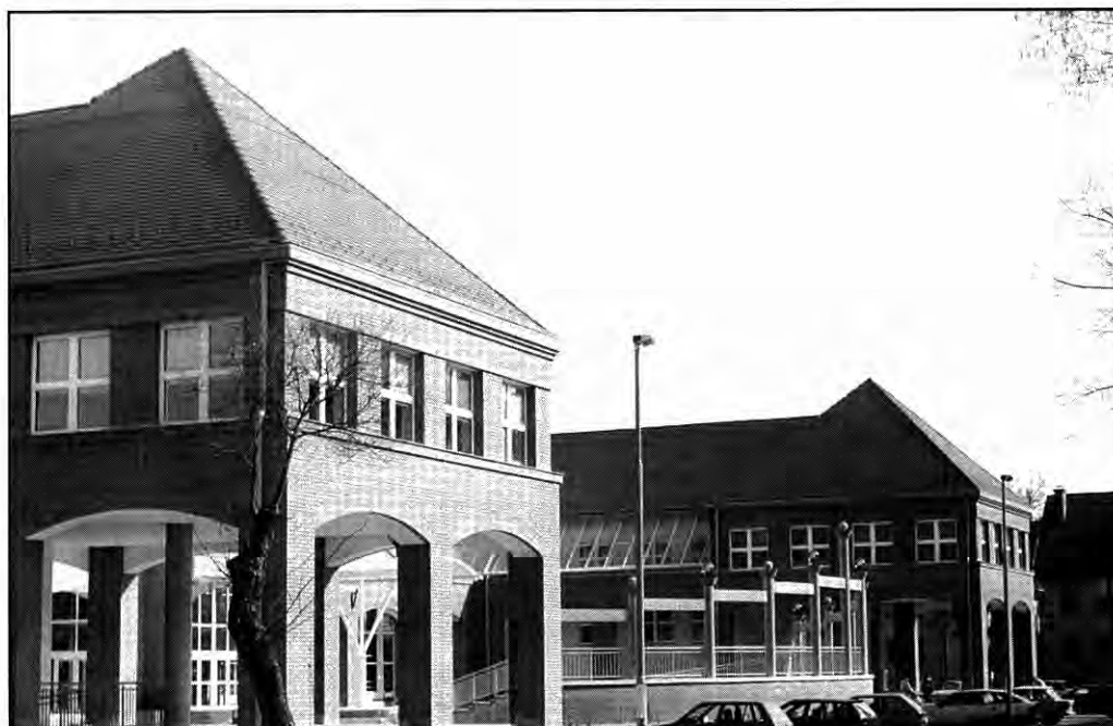
Tóth Árpád Gimnázium épülete - Debrecen
