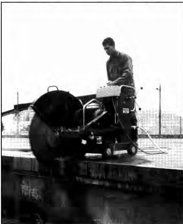
Födémvágás elektromos síkvágógéppel
