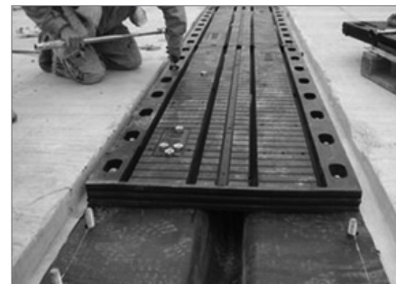
4. ábra Burkolat átvezetése fix csuklóbétag felett
