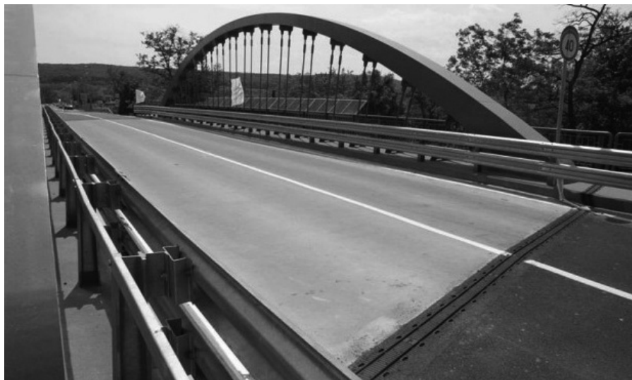
1. ábra Híd tartószerkezetével egybeépített burkolat
