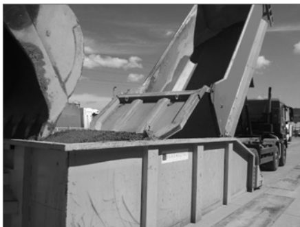
6. ábra Beton ürítése a nyitott konténerbe
