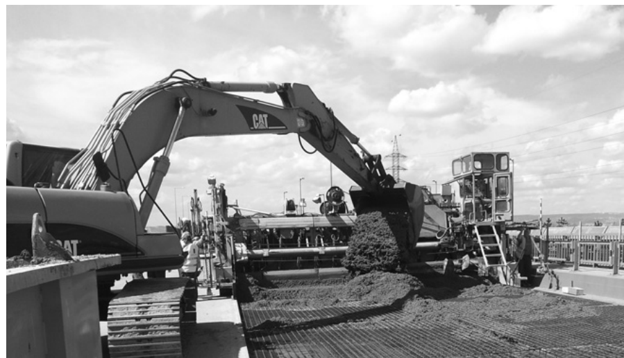
7. ábra Lánctalpas markoló teríti a betont a bedolgozó géplánc elé
