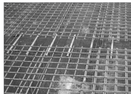
5. ábra Ferde hidakon teljes hálóvasalás szükséges
