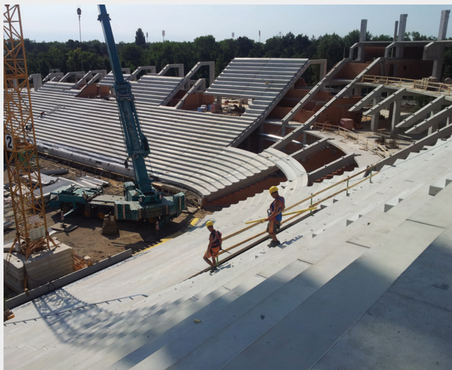
6. ábra Íves lelátó elemek szerelése Debrecenben, a Nagyerdei Stadionnál
