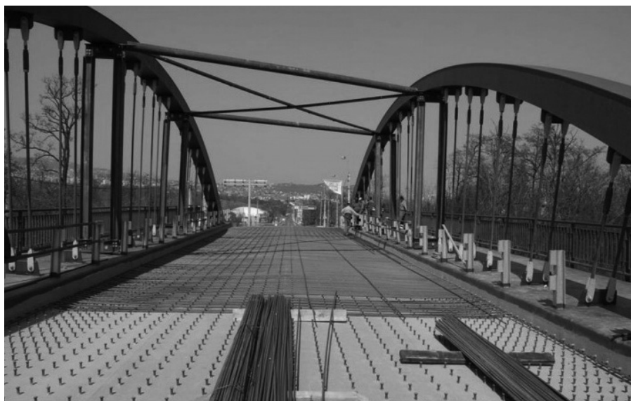
9. ábra Az acél pályalemezzel együttműködő vasbeton lemez egyben a híd burkolatául is szolgál
