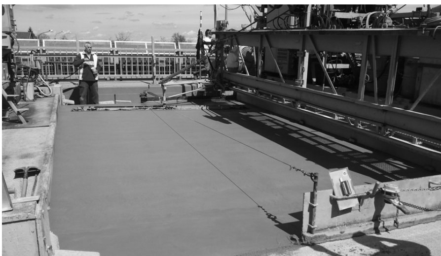
8. ábra A finisher tömörít, szintre húz, simítja a felületet
