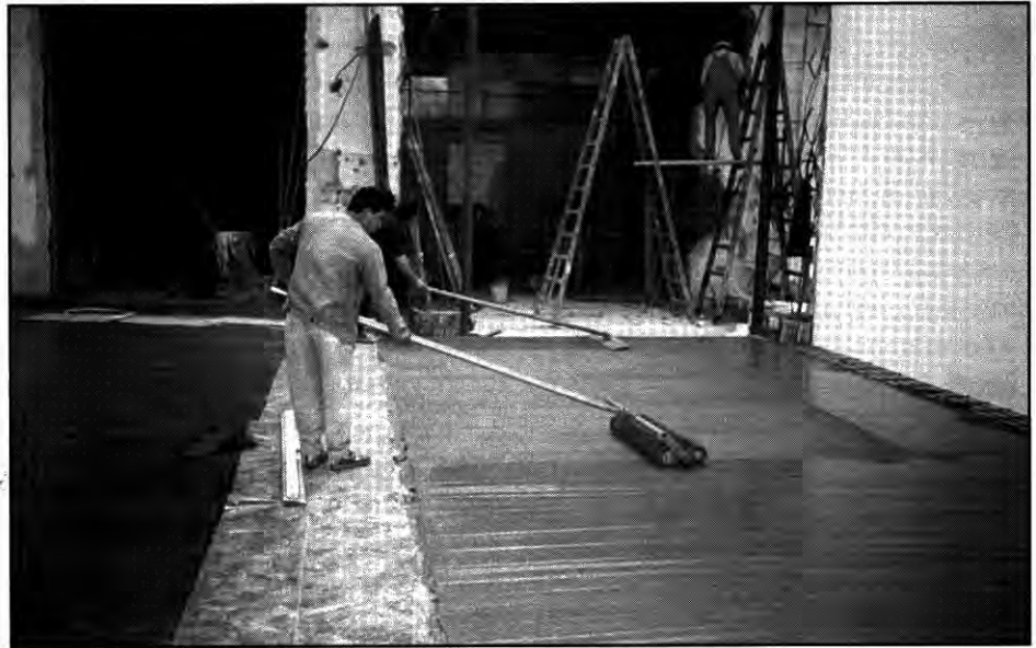
1. ábra Ipari burkolat felületkezelése
