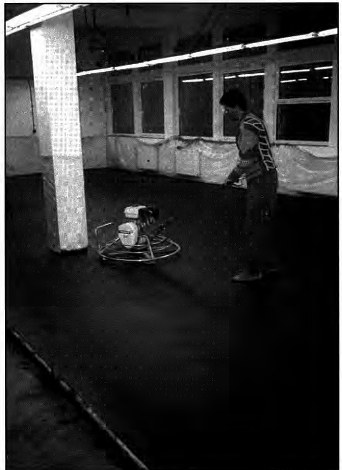
2. ábra Ipari burkolat gépi simítása
