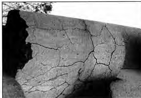
Repedések alkálifém-szilikát reakció következtében. Forrás: Deutscher Beton-Verein E.V.: „Beton-Handbuch” (A kiadás éve ismeretlen.)
