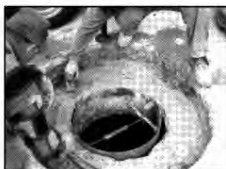
A Sika FastFix-4 bedolgozása és az aknaelemek rögzítése
