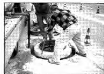
A Sika FastFix-4 bedolgozása és az aknaelemek rögzítése
