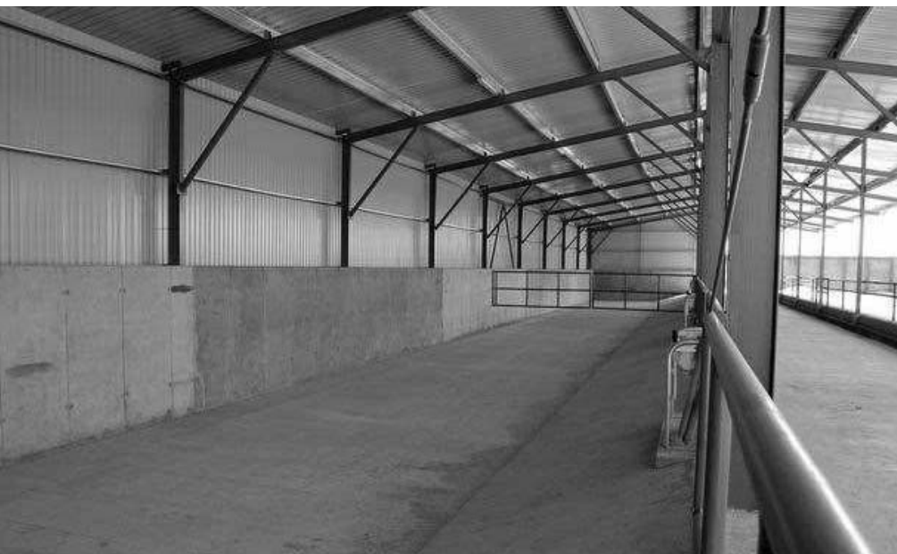
1. ábra Mezőgazdasági épület padlója szálbetonból
