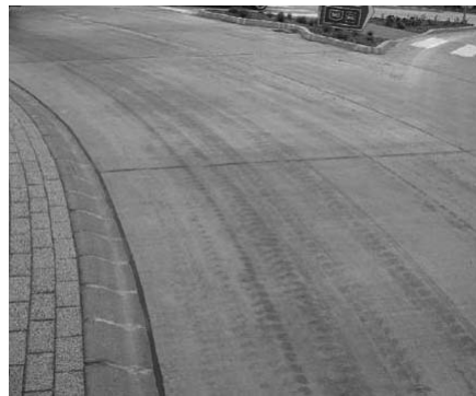
4. ábra Az eltérő pályaszerkezeti típussal kialakított körforgalmak járófelületének tönkremenetele – a bal oldali képen a félmeres pályaszerkezeten maradó alakváltozás és felületi hibák jelentkeznek, a jobb oldali képen a merev pályaszerkezet esetén a felület nem változik, csak a súrlódási ellenállás csökken egy előre meghatározható mértékig
