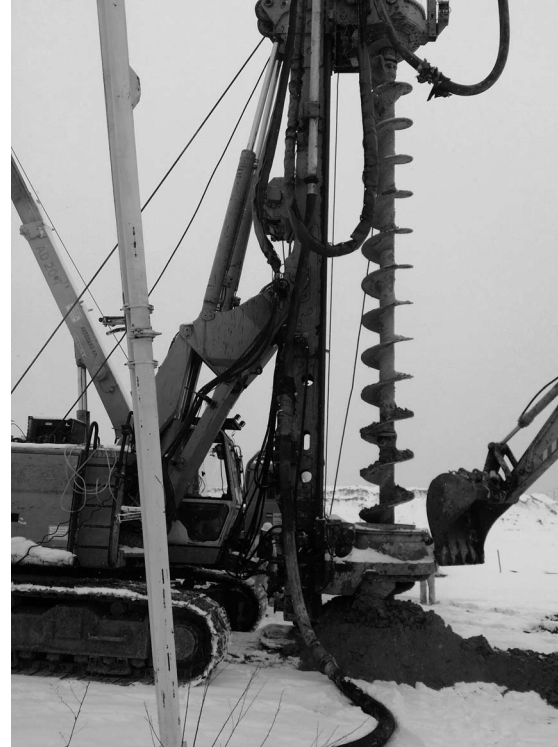
4. ábra Próbacölöpözési munkálatok
