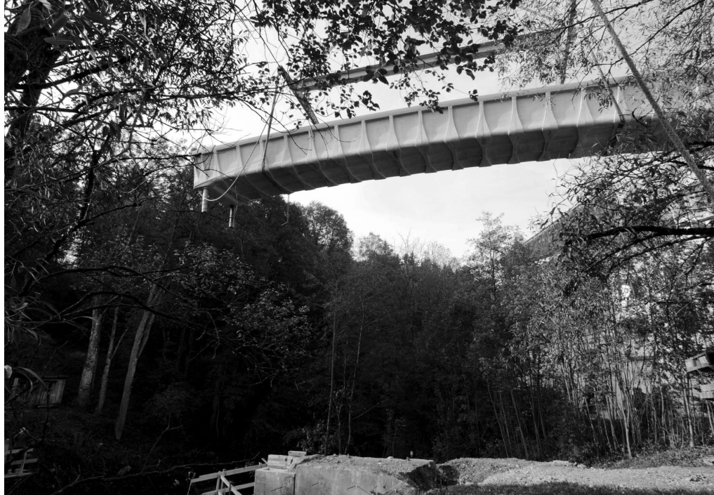
4. ábra Textilbeton híd beemelése Kemptemben
