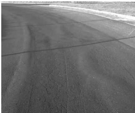
4. ábra Az eltérő pályaszerkezeti típussal kialakított körforgalmak járófelületének tönkremenetele – a bal oldali képen a félmeres pályaszerkezeten maradó alakváltozás és felületi hibák jelentkeznek, a jobb oldali képen a merev pályaszerkezet esetén a felület nem változik, csak a súrlódási ellenállás csökken egy előre meghatározható mértékig
