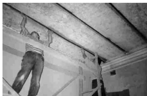
1. ábra Födém megerősítése
