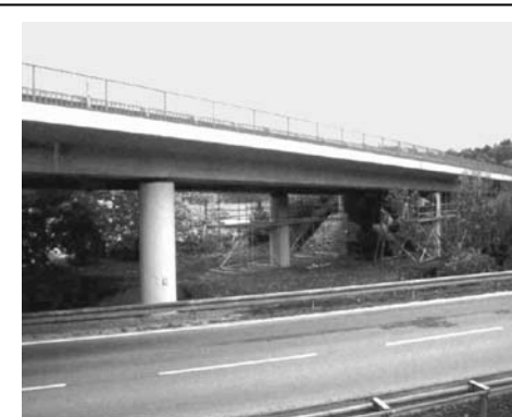
4. ábra Sika LEOBA CarboDur LC II. megerősítés.
