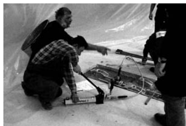
7. ábra Sika StressHead megerősítés. AUDI AG – Győr.
