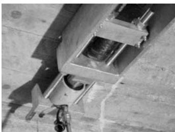
6. ábra Sika StressHead megerősítés. Escher hid – Zürich.
