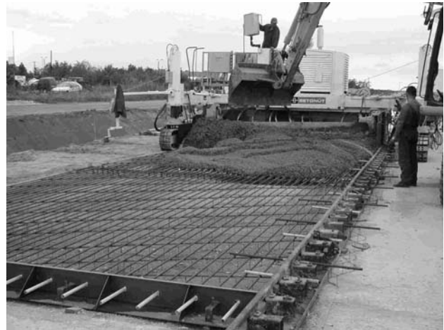
1. ábra Folyamatosan vasalt pályaszerkezet
