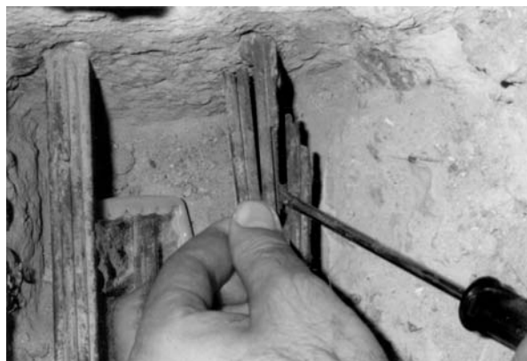
7. ábra A feszítópázmák elszakadt acélszalai
