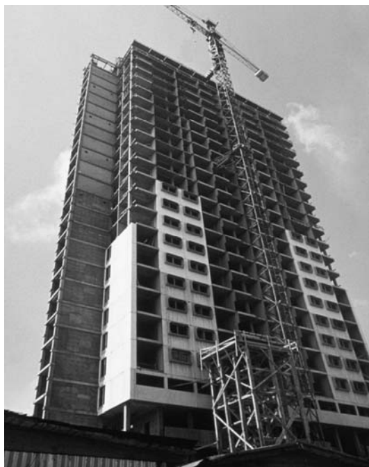
3. ábra A pécsi 25 emeletes „Magasház” szerelés közben
