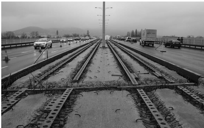
1. kép A visszabontott pályalemez a kibontott sínvályúkkal
