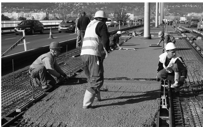
4. kép Pályalemez beton bedolgozása, lejtésképzés és simítás
