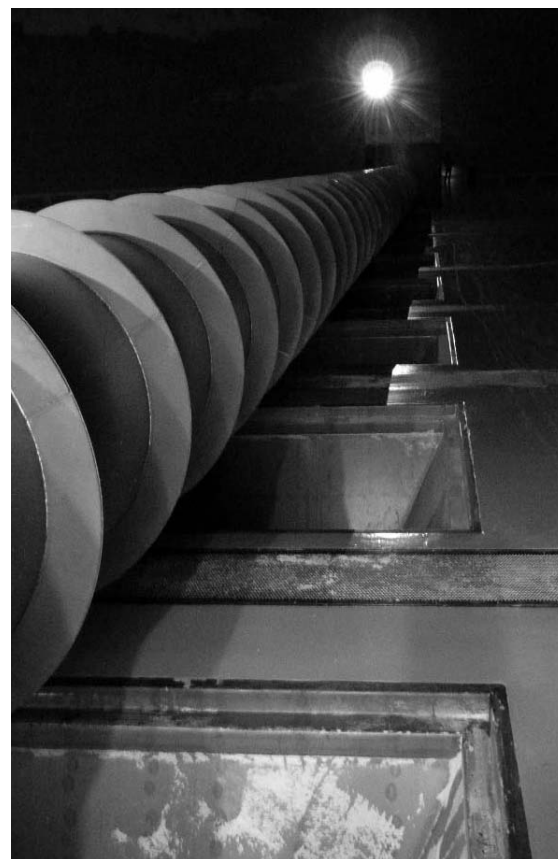
4. kép A leürített siló károsodásmentes felülete a kihordó garatnál
