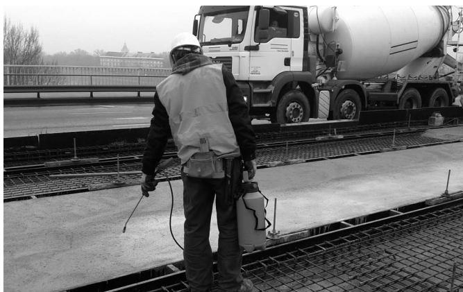
5. kép Beton utókezelése párazáró szer felhordásával
