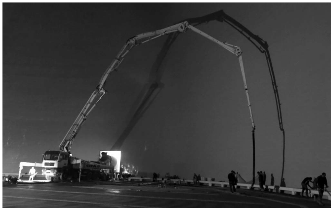
2. kép A betonszivattyú munka közben
