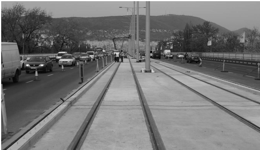
6. kép Az elkészült pályalemez és a szegélyek a dilatáció környezetében
