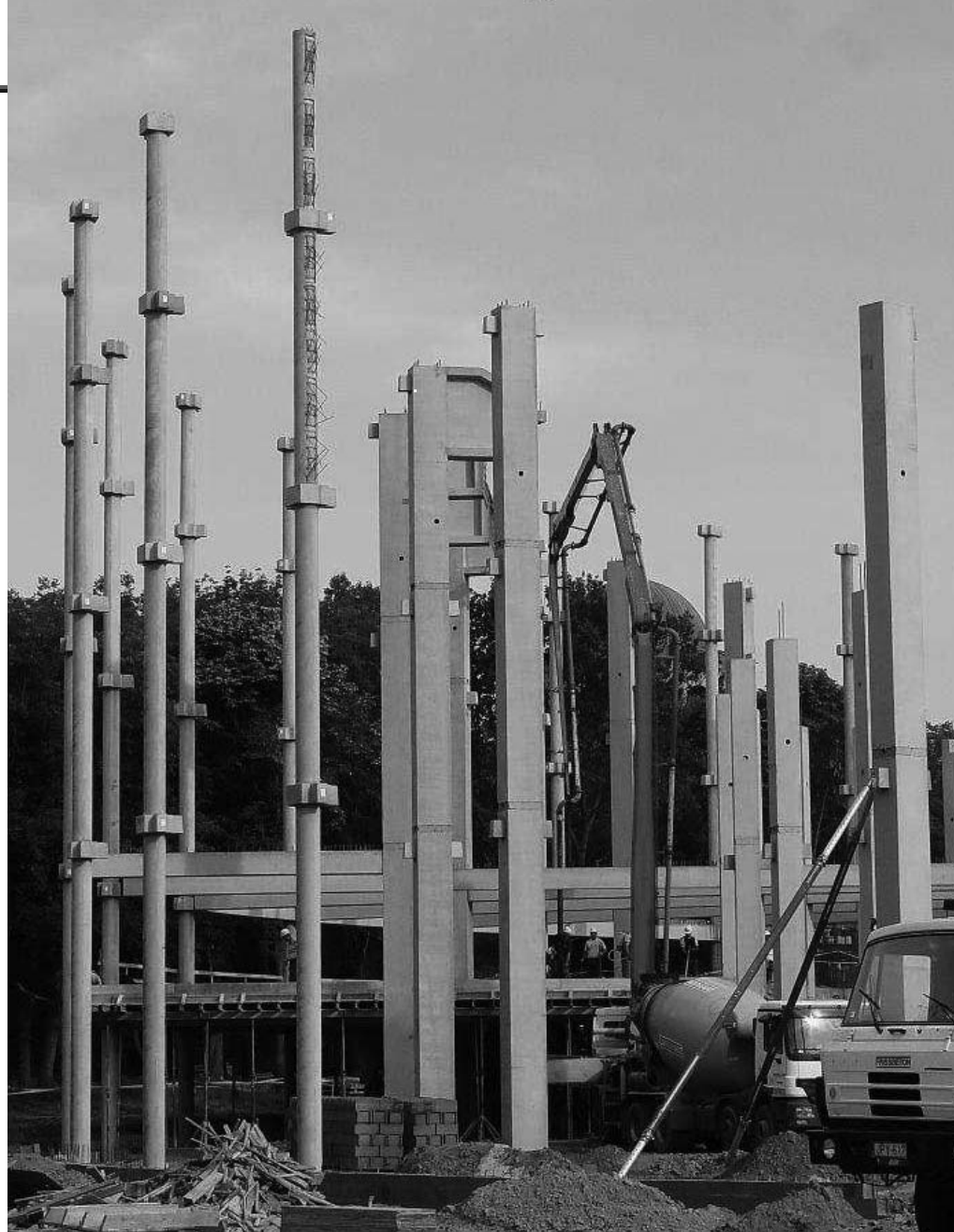
2. kép Az első képek a stadion építéséről: a 22 m hosszú, 45 cm átmérőjű pillérek a háromágú konzollokkal megdöbentették a laikusokat, de a szakmabelieket is!
