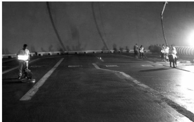
3. kép A kirajzolódó betonozási szakaszok
