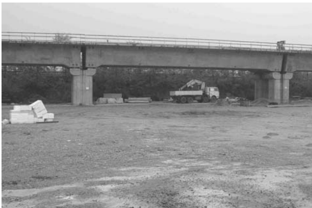
5. ábra Előregyártott híd részlete
