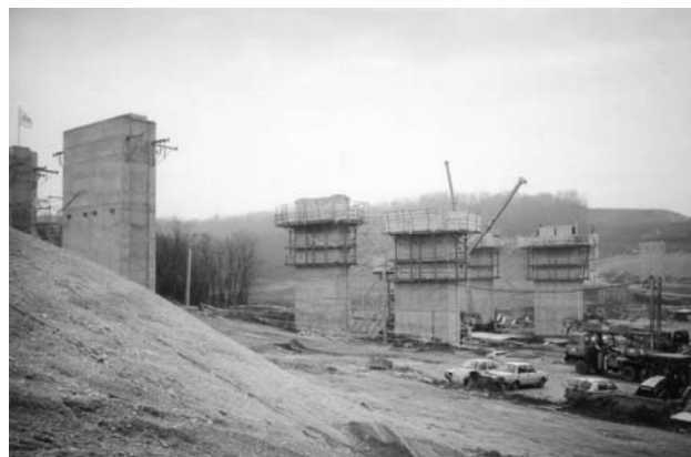
3., 4. ábra Az M7 autópályán az S16 jelű völgyhid pillérének építése
