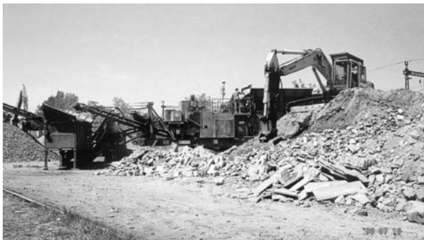
1. ábra Bontott építési törmelék feldolgozó gépsor
