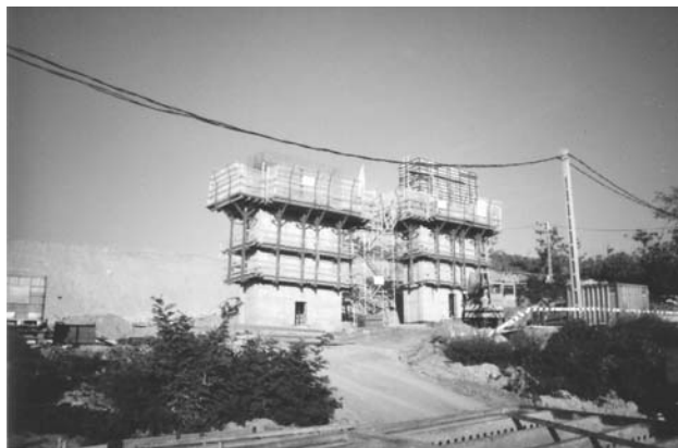
3., 4. ábra Az M7 autópályán az S16 jelű völgyhid pillérének építése
