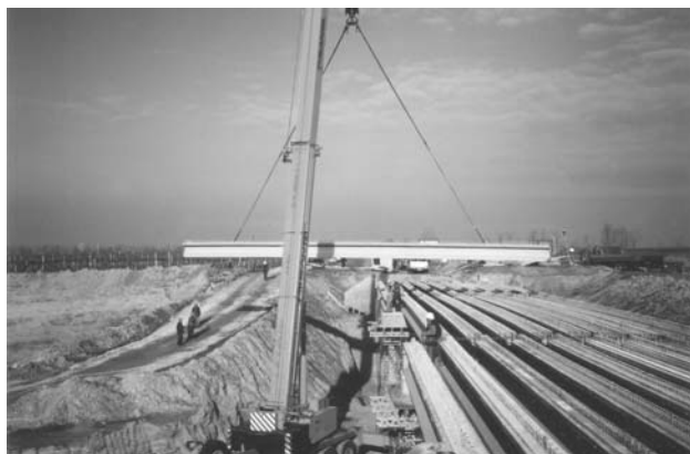
2. ábra M7 autópálya, az S34 jelű híd tartóinak rakása
