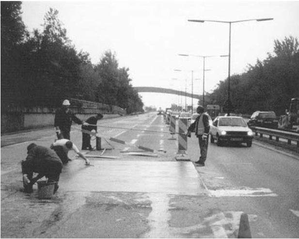
3. ábra Egy „12 órás beton” beépítése az A23 autópályán Bécsben [13]
