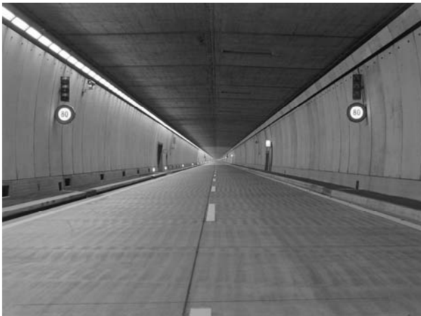
2. ábra Világos betonburkolatok növelik a biztonságot
