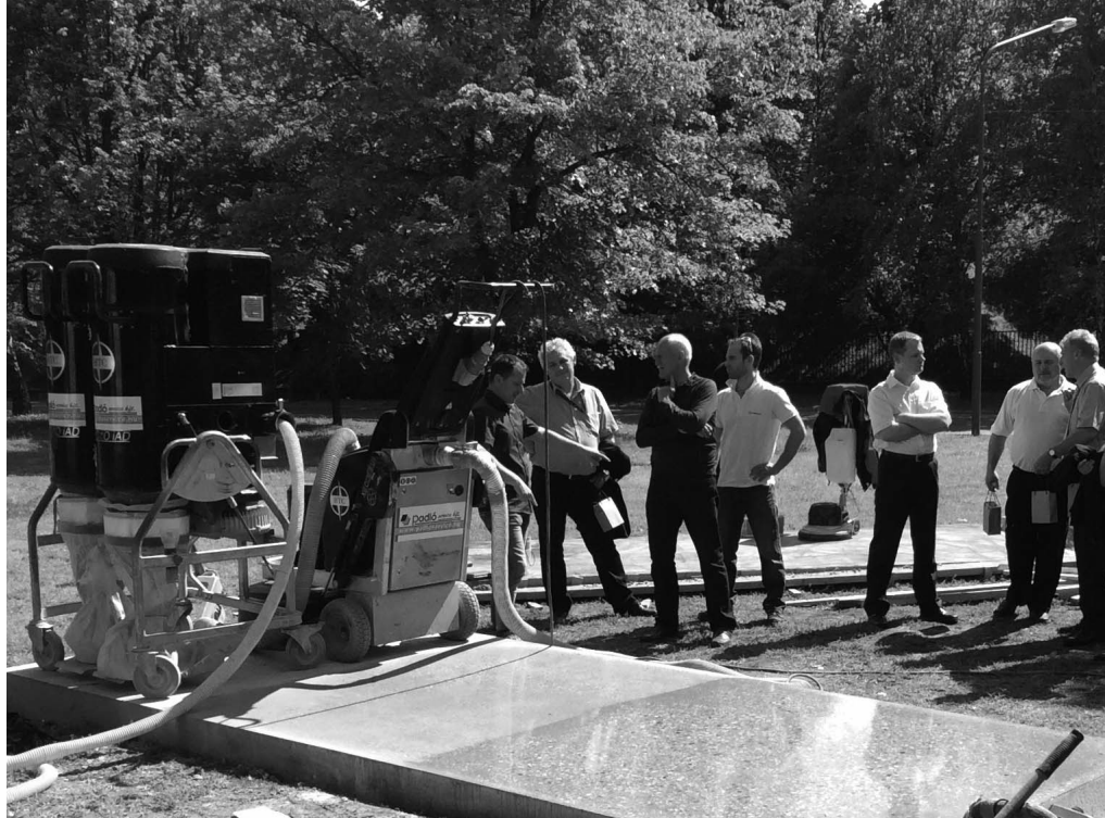
3. kép A HTC Superfloor eljárás bemutatója a gyáruvarton
