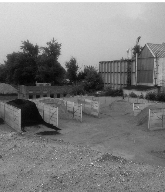
3. kép Adalékanyag depónia a betongyár udvarán
