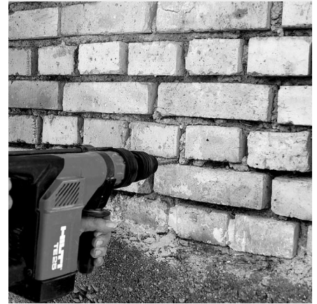
7. kép Az injektáló lyukak kifúrása
