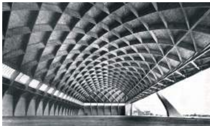
4. kép Repülőgép hangár héjszerkezete
