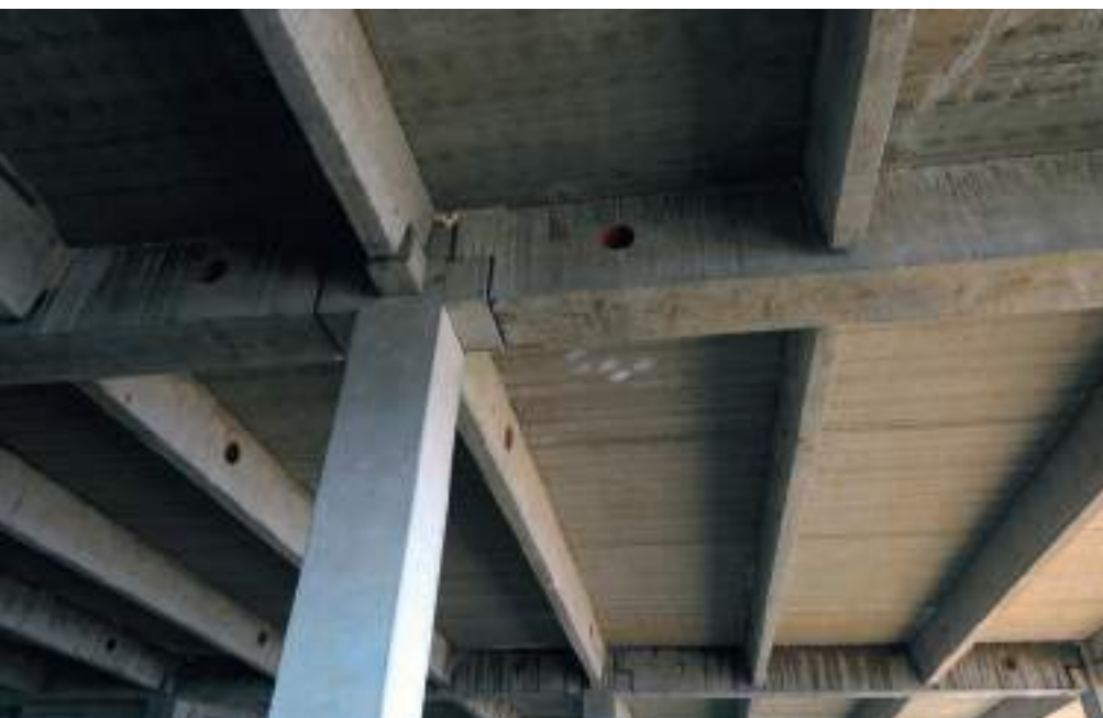
2. kép A tartószerkezet alulnézetből
