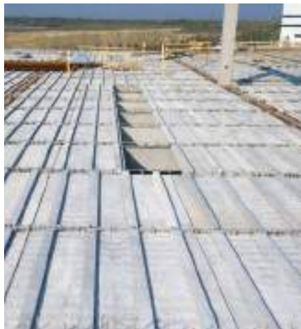
3. kép A felülbordás zsalupanelre a vasszerelés közvetlenül ráfektethető
