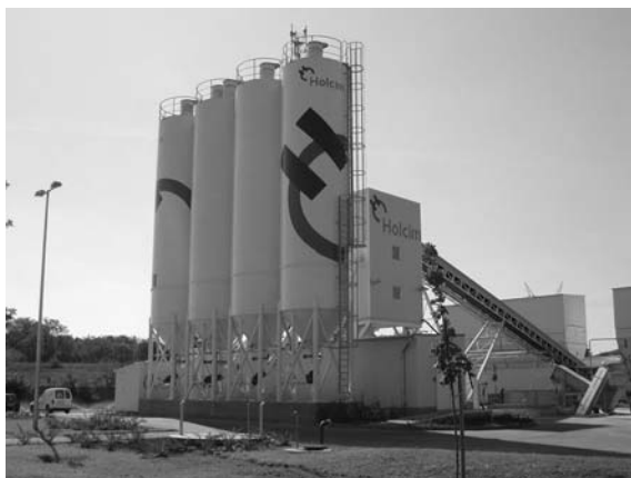
1. ábra A Rákospalotai Betongyár
