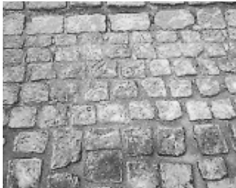
3. ábra Kültéri burkolat javítása
