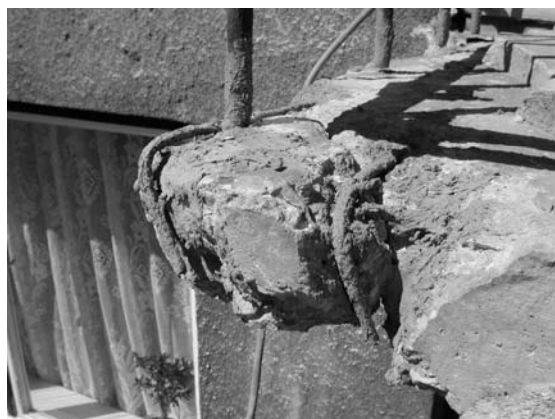
1. ábra A laza betonrészeket eltávolították, korrózió ellen Murexin Ferrosave betonacél védőszert használtak
