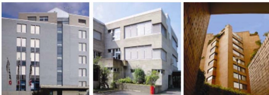
5. ábra Épületek homlokzati képei
