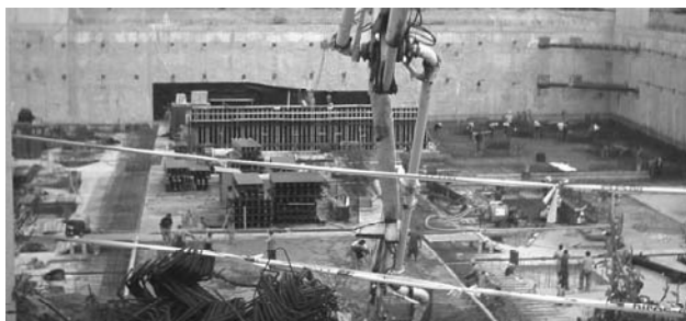
1. ábra Vízáró alaplemez készítése Kecskeméten
