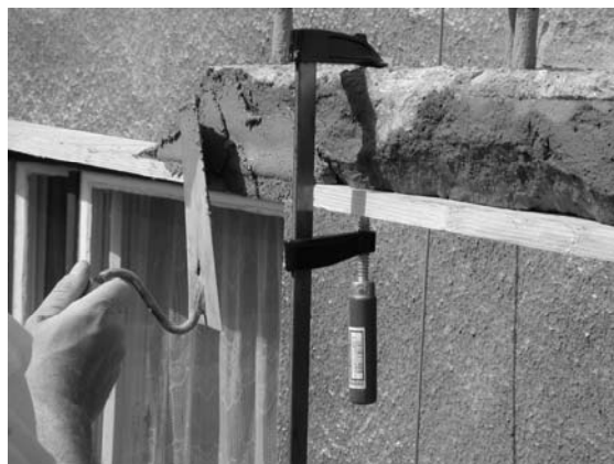
3. ábra Javítás Murexin durva betonjavítóhabarccsal
