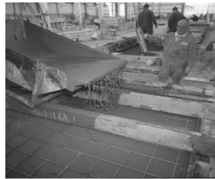
7. ábra Betonozás előregyártó üzemben
