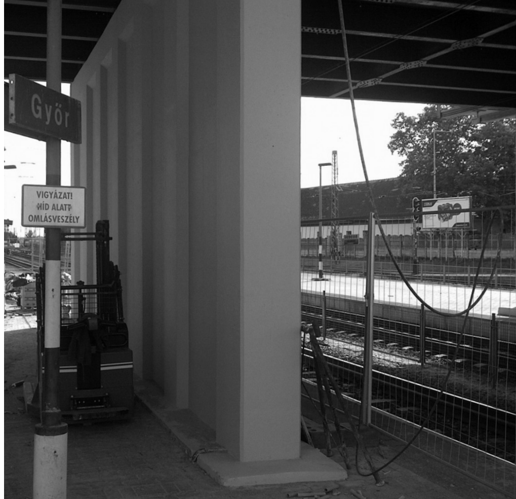
4. kép Az elkészült falpillér
