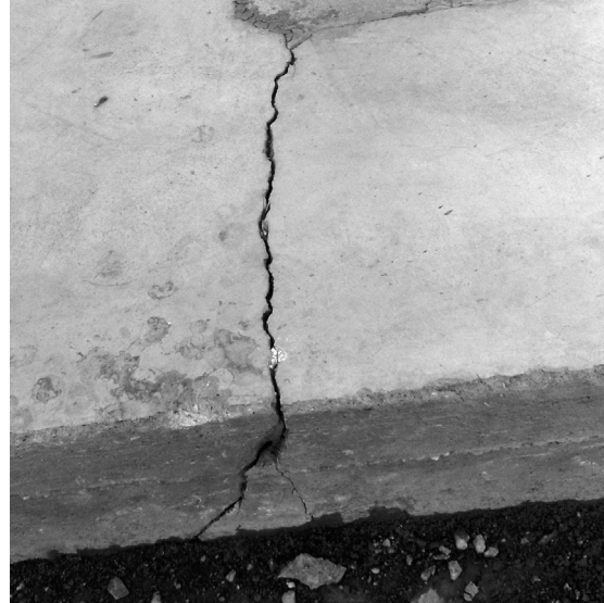
2. kép A duzzadás miatt megrepedt betonlemez
