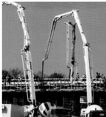
9. kép Pályalemez betonozása az M0 autótúttal egyik hídján
