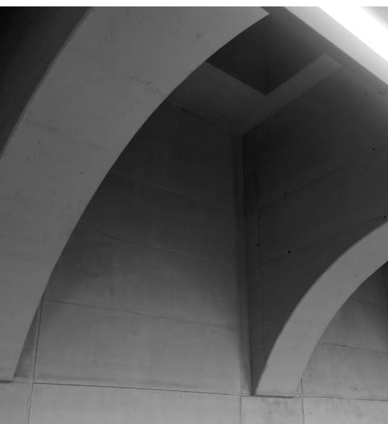
14. kép Látszóbeton ívek és fal az M4 metró vonalán
