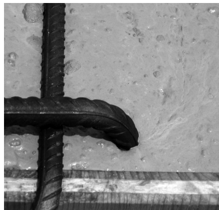
12. kép Öntömörödő beton felülete a zsaluzatban
