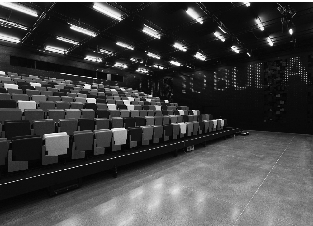
1. kép Szálerősített betonpadló a rendezvényteremben
