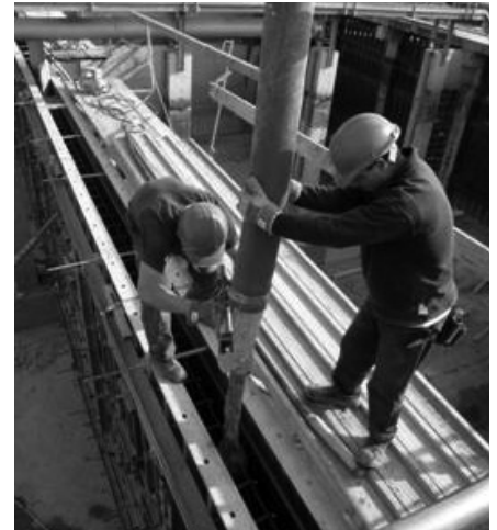
10. kép Magas fal betonozásakor ornaménycsövet használnak segédeszközként
