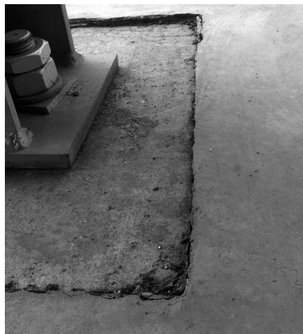
1. kép A duzzadó agyagréteg több cm-rel megemelte a betonlemezt
