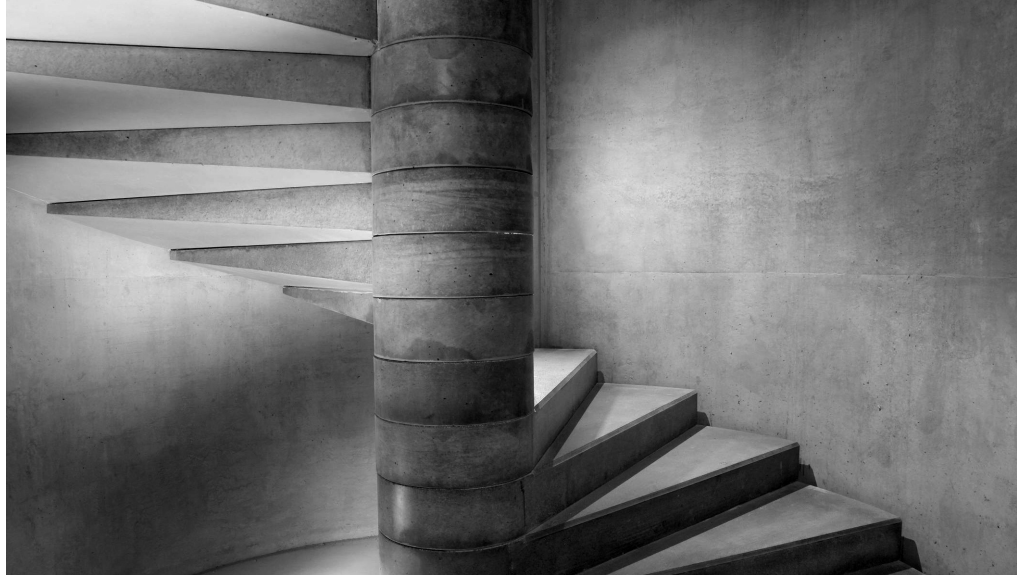
2. kép Előregyártott beton csigalépcső a várfalnál
