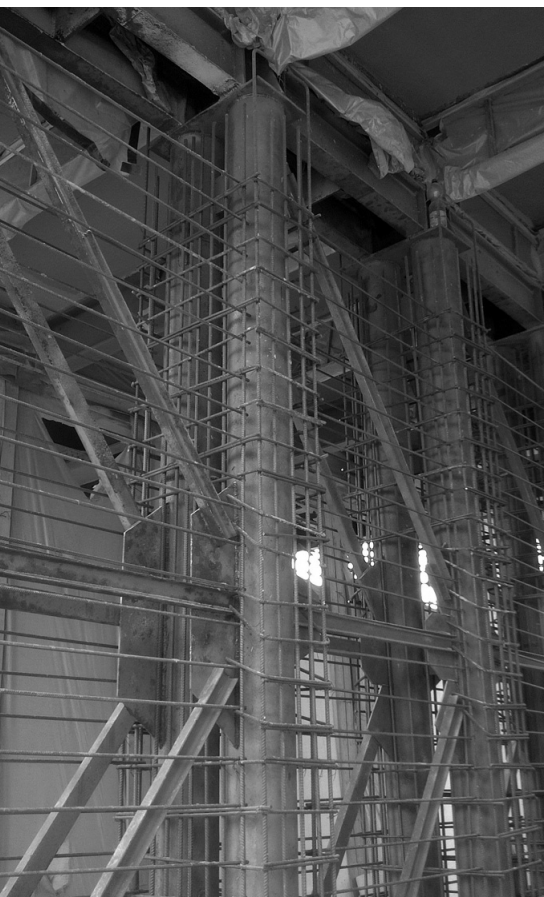
1. kép Előkészületben a vasalás
