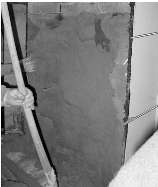
6. ábra A feltárt háttérinjektálás
