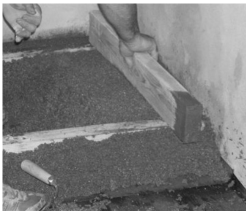
1. ábra Bedolgozás íves pallóval
