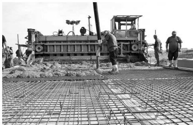
3. ábra A beton szivattyúzása a betonacél háló közé
