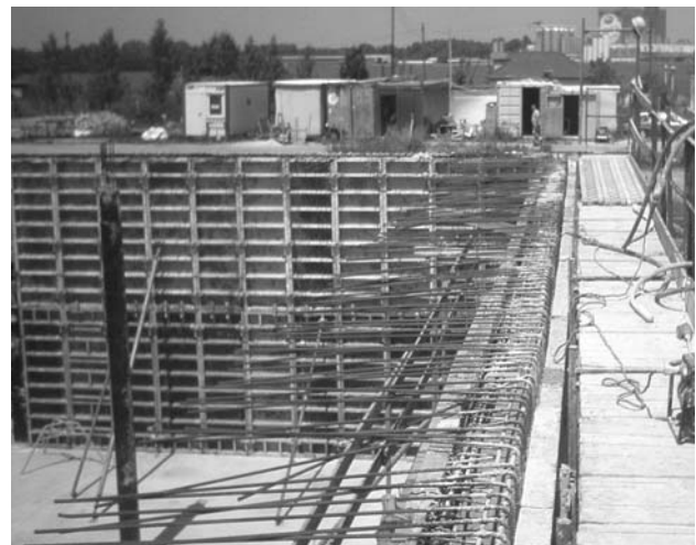
2. ábra Elkészült a vasszerelés és a zsaluzás
