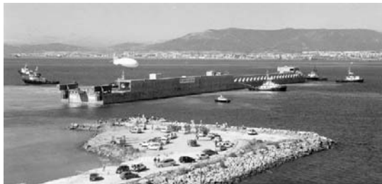
6. ábra A szárazdoki megnyitása után megkezdődött a létesítmény Monacóba úsztatása
