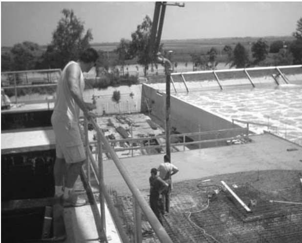
1. ábra Az alaplemez betonozása
