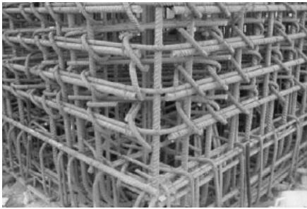
3. ábra A betonacélok átmérője 12-40 mm között volt
