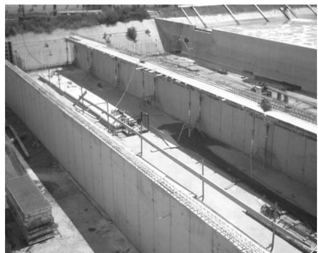
3. ábra A kiszaluzott szerkezet
