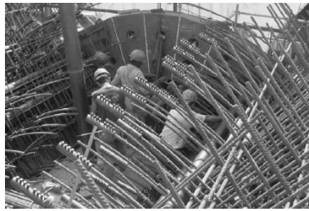
4. ábra A feszítőpásmák, rudak átmérője 60-141 mm között volt
