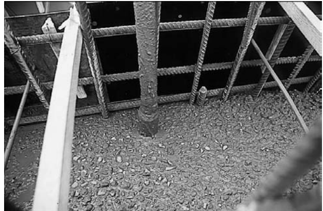
5. ábra A beton vibrálása
