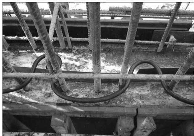
6. ábra Az utókezelés a beépítést követően azonnal megkezdődött
