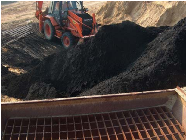
1. ábra A pernye felrakása a tárolóbunkerbe
