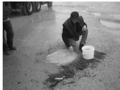
4. ábra A felület meghintése zúzott homokkal
