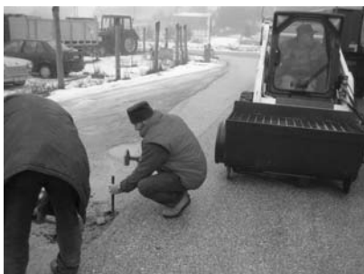
2. ábra A felület előkészítése
