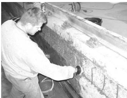
2. ábra Tapadásjavító habarcs felvitele
