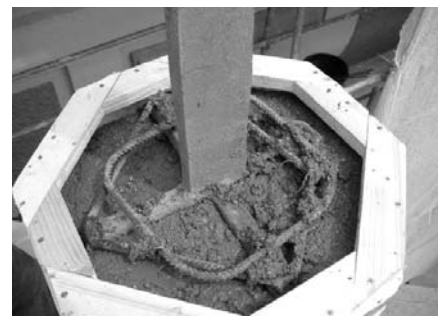
9. ábra Az új kalapdísznél a betontakarás helyenként csak 1 cm, hasonlóan a régibehez
