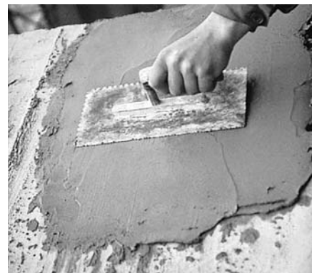
4. ábra Finom javítóhabarcs felvitele
