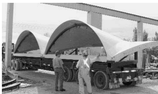
7. ábra A 2 cm vastag héjelemek szállítása
