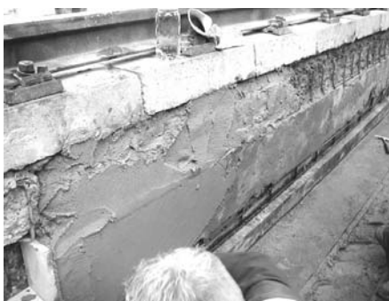
3. ábra Durva javítóhabarcs felvitele
