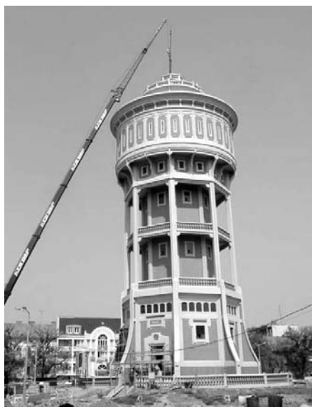
10-11. ábra Helyére kerül (remélhetőleg újabb 100 évre) az új kalapdísze
