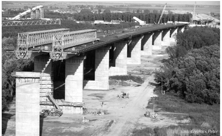
1. ábra A dunaújvárosi Duna-híd nyugati oldali ártéri szerkezetei és a távolban a mederhíd a látogató központból
