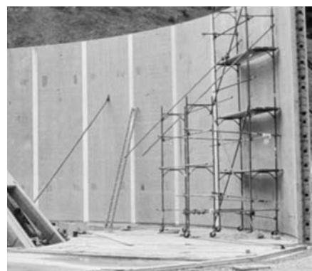
1. ábra Utólagos hézaglezárás
