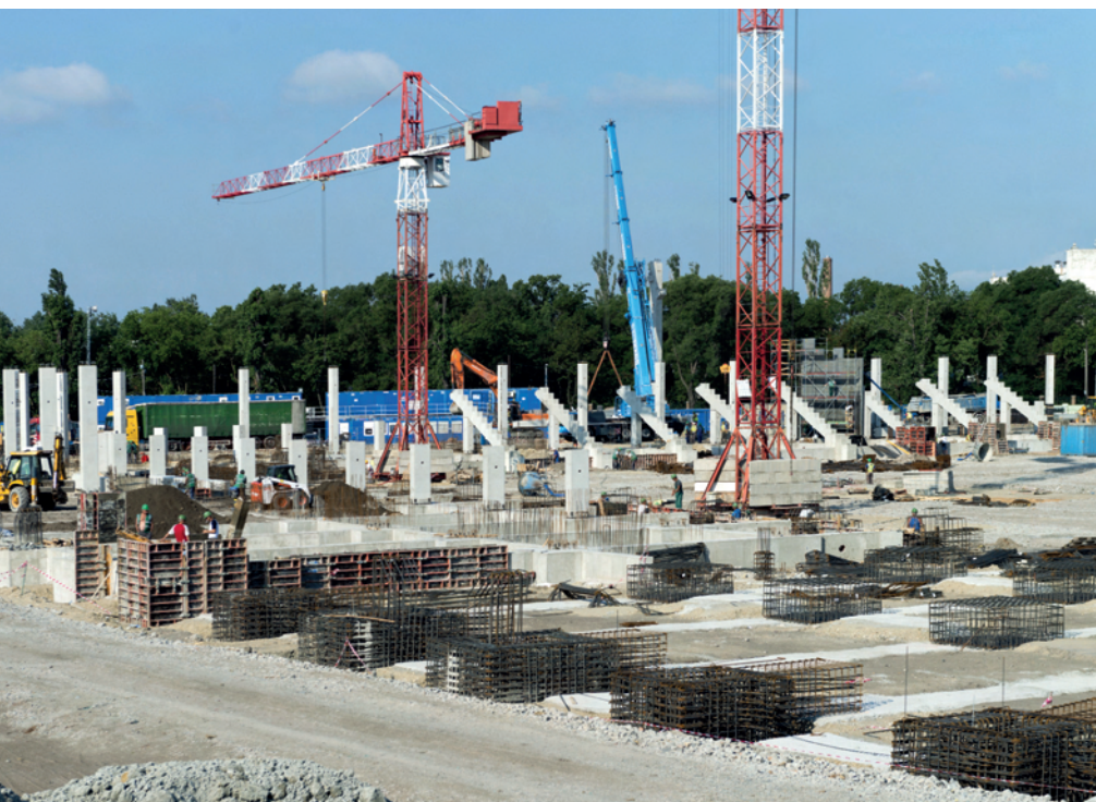
3. ábra A lelátószerkezet alapozási munkái (fejtömbök és talpgerendarács építése)
