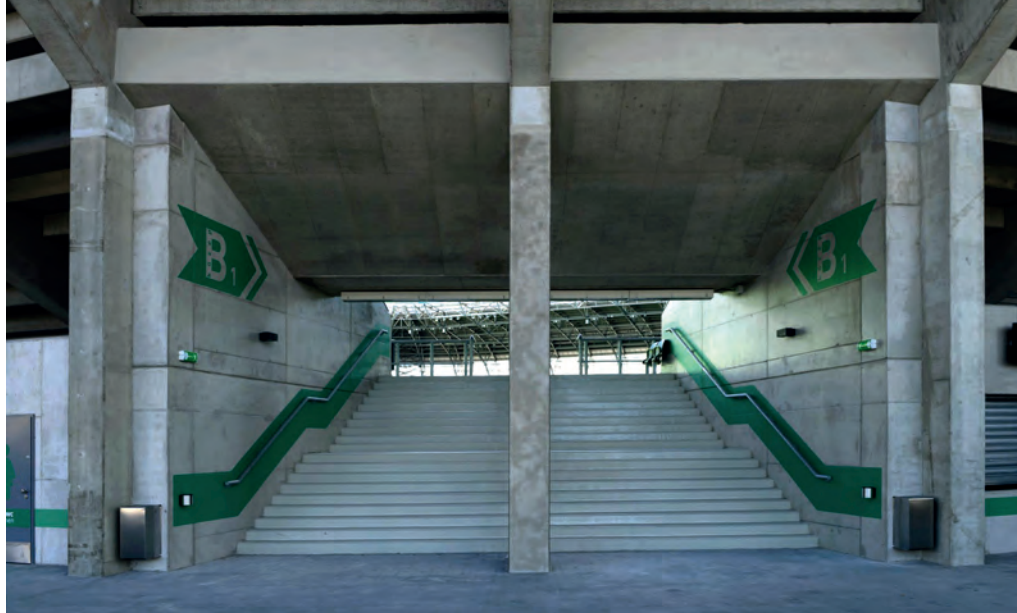
4. ábra Látszóbeton lépcsőház
