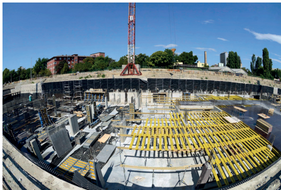
1. ábra Fejpület, mélygarázs építése
