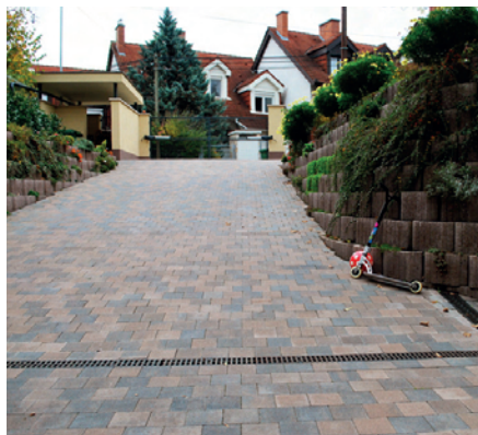
1. kép Gépkocsibeálló változatos térkő burkolattal
