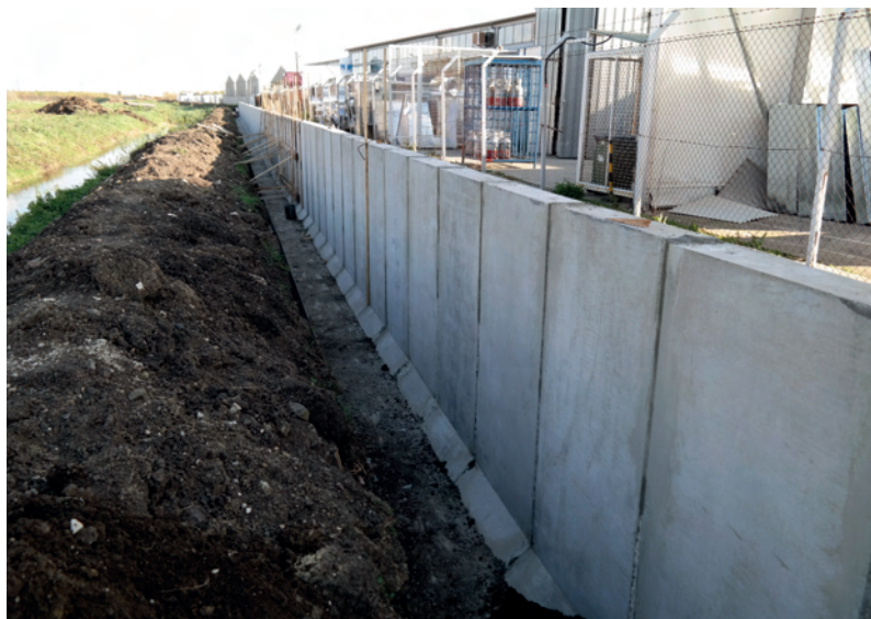
2. kép Támfalak helyszíni beépítése
