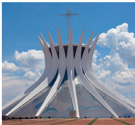
9. kép Oscar Niemeyer - Cathedral of Brasília. Hiperboloidon szerkezet
