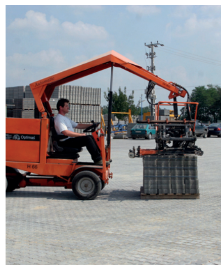
4. kép Ipari környezetben térkőrákó géppel fektetett, kitűnő kapcsolódású térkő
