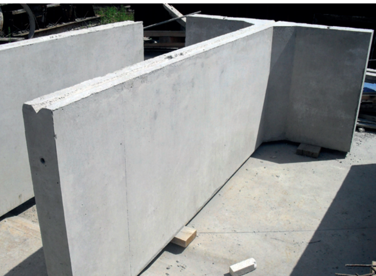
1. kép Előregyártott támfal a telephelyen
