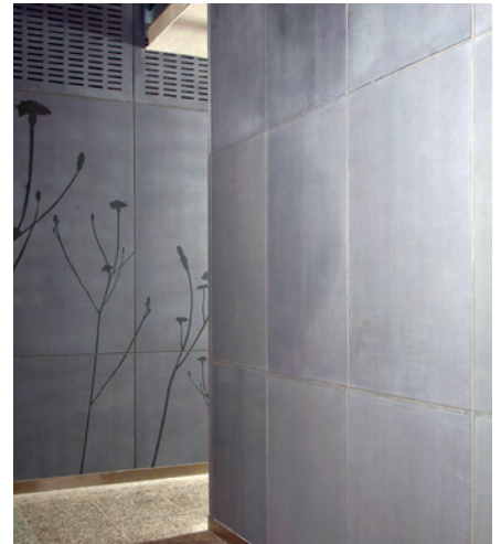
18. kép Matricás betonfelület az M4 metrő, Bikás parki állomásán
