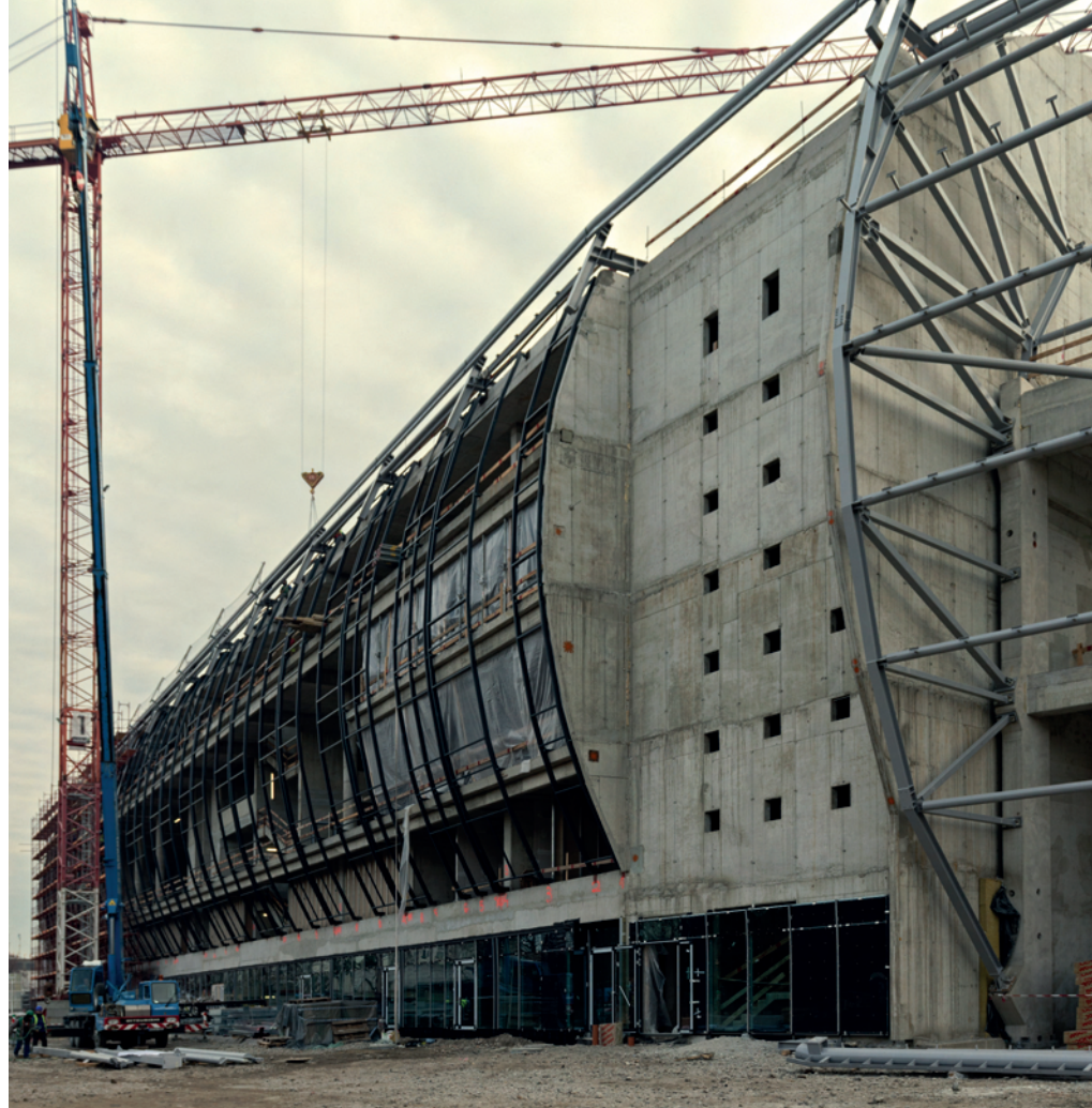
2. ábra A fejpület íves homlokzata (határoló falak íves bütüfelülettel, egymás fölé kilógó födémelek)
