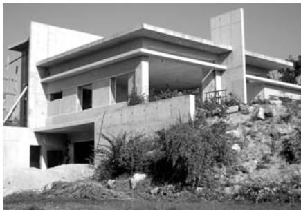
5. ábra A beton párkányokat meg kell védeni az időjárás viszontagságaitól
