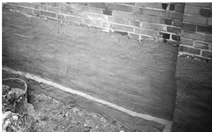
4. ábra Superflex D2 szigetelés felhordása
