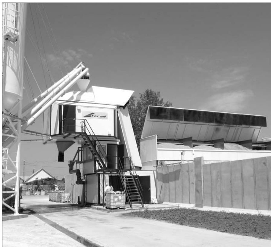
1. ábra Az elkészült betongyár
