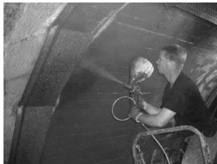
2. ábra Vízszigetelő réteg felhordása
