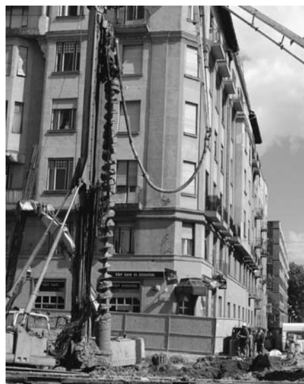
4. ábra A cölöp helyének kifűrése CFA fúrógéppel
