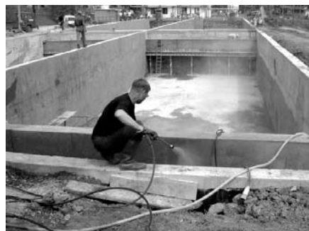
1. ábra Szennyvíztisztító medence betonfelületének előkészítése
