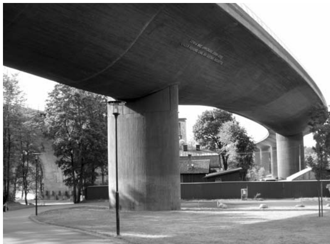
7. ábra Íves vasúti híd, színes betontól öntve
