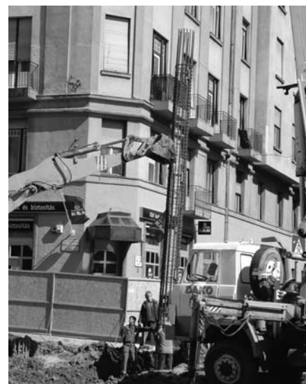
5. ábra A betonacél armatúra leengedése
