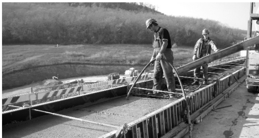
1. ábra Beton bedolgozása
