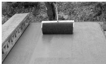
4. ábra A beton felületének érdesítése műfüves bengerral
