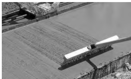
3. ábra A beton felületének érdesítése seprűvel
