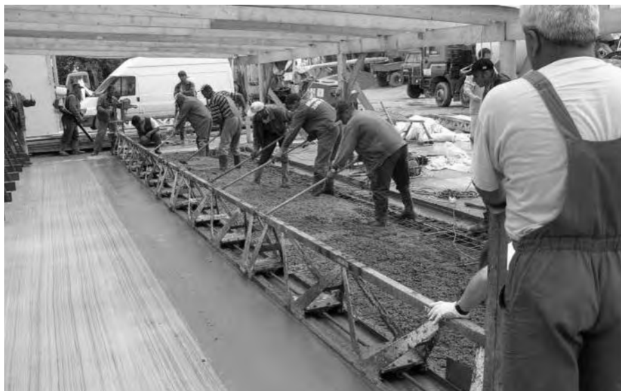
2. ábra Felületképzés TREMIX SVE típusú vibrációs lehúzógerendával
