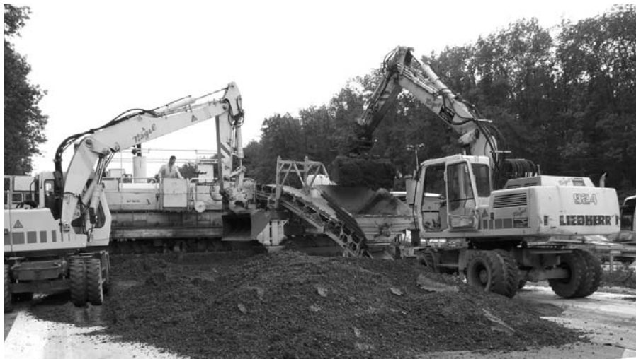
3. ábra A beton feladása a gépláncba Németországban
