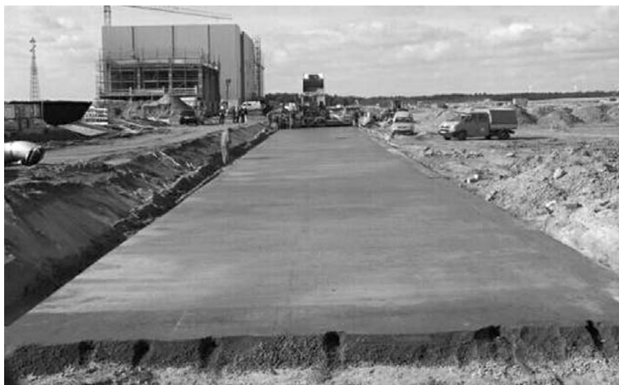
5. ábra Kompaktbeton útfelület Arneburgnál
