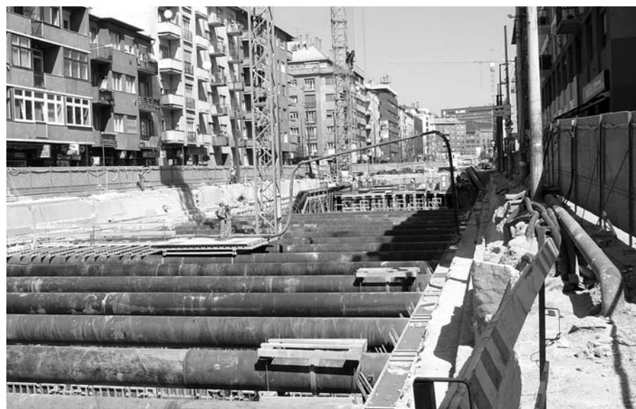
1. ábra Gerendák betonozása. A kb. 130 m hosszú betonozócső vezetése bal oldalon, majd középre behozva, daruval felemelve és a megfelelő helyre irányítva
