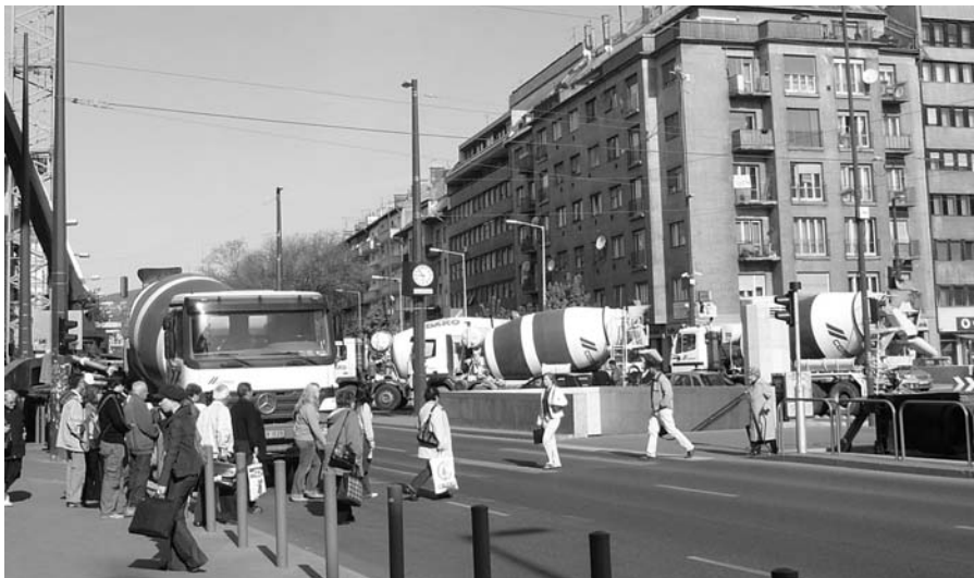
5. ábra A zárófödém 1. ütemének betonozása. Érkező mixerek a Bocskai úton
