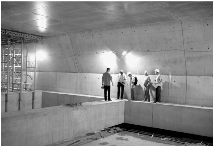
7. ábra A "Látszóbeton Bizottság" szemléje az elkészült zárófödém alatt
