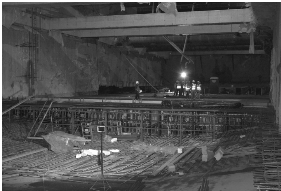
2. ábra Az Etele téri állomás 2007. februárban. Elkészült az alaplemez vasszerelése, indulhat a betonozás
