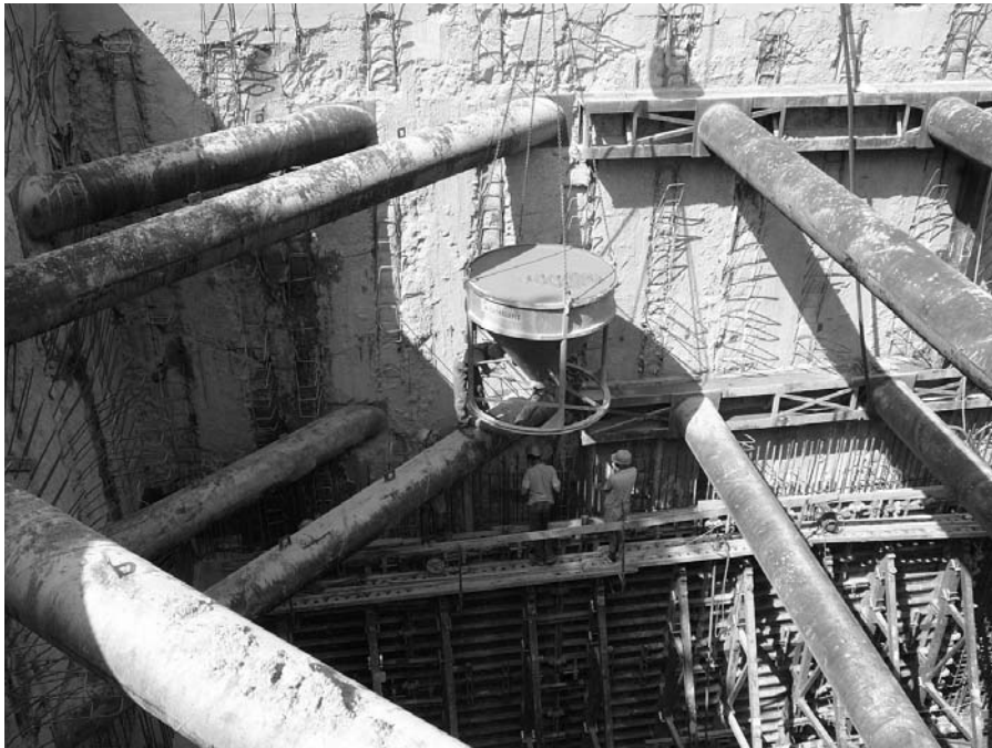
6. ábra A Kanizsai utcai szellőző műtárgy bélésfalainak betonozása konténerrel
