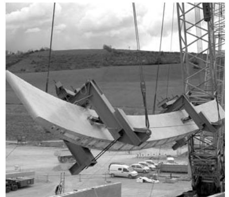
6. ábra A millau-i viadukt autópálya kapujának előregyártott tetőelemei Franciaországból
