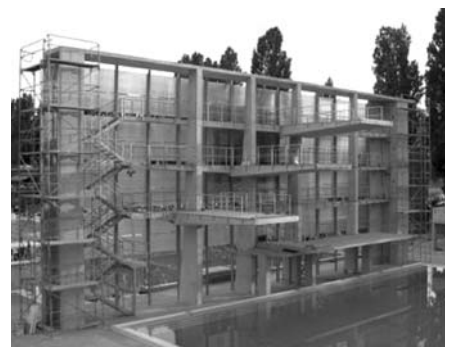
8. ábra A budapesti Hajós Alfréd Sportuszoda transzportbetonból készített öntömörödő látszó betonja
