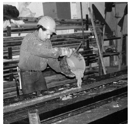
9. ábra Öntömörödő beton használata németországi előregyártó üzemben
