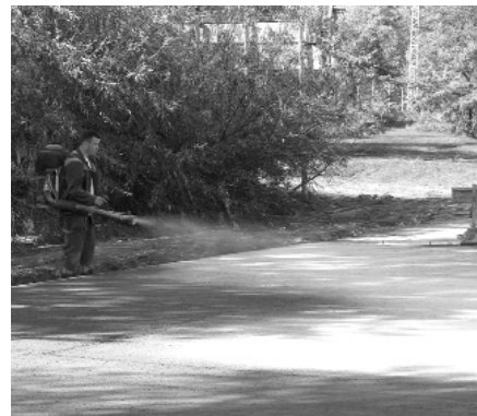
2. ábra Felületvédelem párazárószerral
