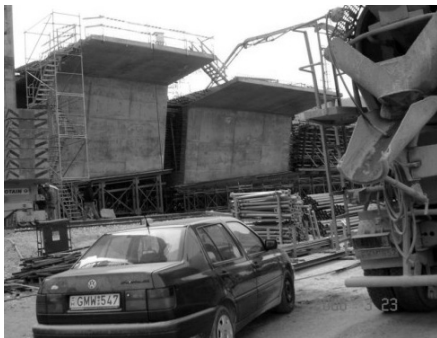
10. ábra Transzportbeton és építéshelyi előregyártás az M7 autópálya köröshgyi völgyhídjánál
