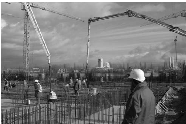
11. ábra Transzportbeton használata Budapesten, a csepeli szennyvíztisztító építésénél
