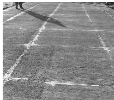
3. ábra Hézagkiosztás az elkészült burkolaton
