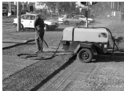
1. ábra A fogadó felület batékony tisztítása
