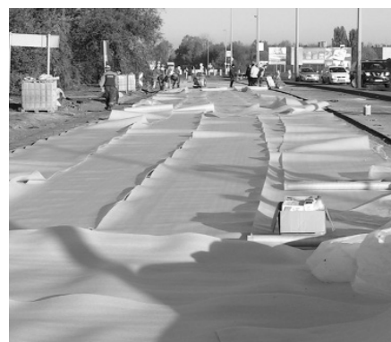
4. ábra Védelem az éjszakai hidegtől hőszigetelő takarással
