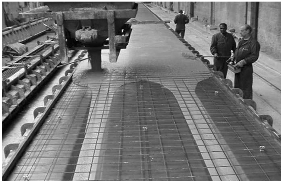
4. ábra Vasalt, nagy méretű elem betonozása öntömörödő betonnal előregyártó üzemben
