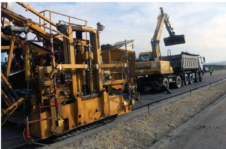
1. kép Beton pályaburkolat készítő géplánc kivitelezés közben
