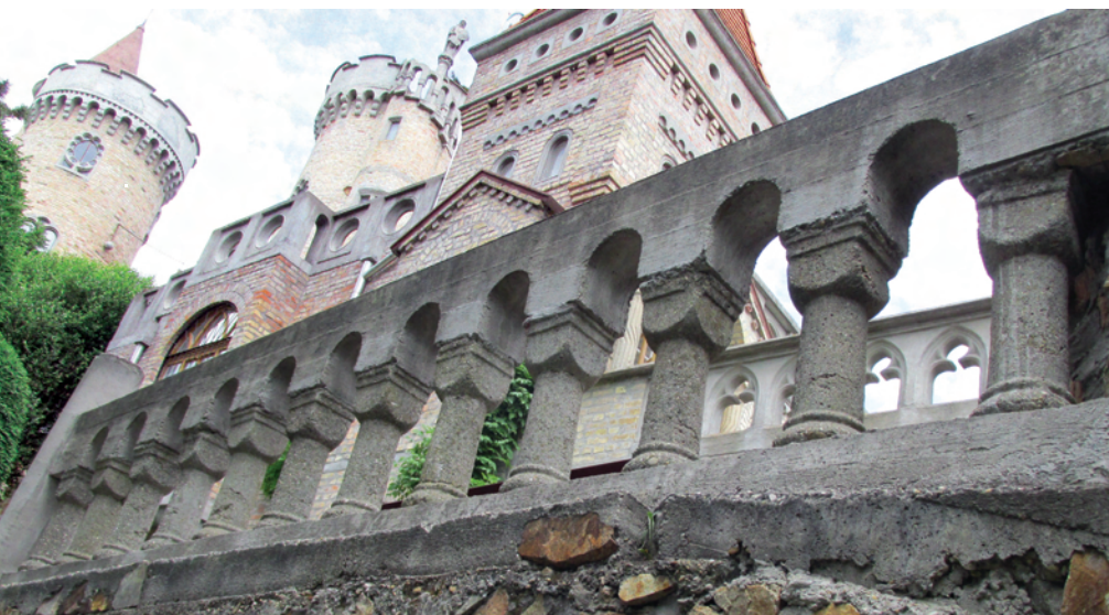
5. kép A homlokzati részleten jól látszik, hogy itt a beton nem szerkezeti, hanem díszítő elem, a korra jellemző megfogalmazással. Visszagondolva az idomok zsaluzási lehetőségére, nagyszerű felületi struktúrát ért el a mester. Tömör szerkezeti megjelenése ellenére a mellvéd és a többi homlokzati betondísz elem nem nyomja agyon a látványt
