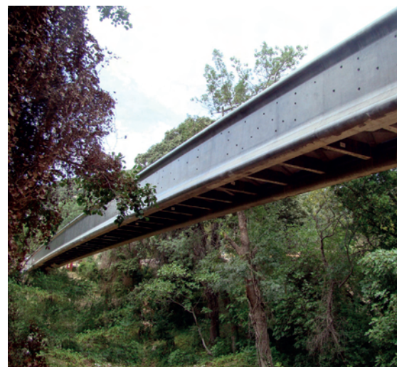
8. kép Az Ördög híd (Pont du Diable) Franciaországban 1,8 méter magas szerkezet, amely 70 métert hidal át alátámasztás nélkül [11]
