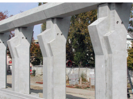
1. kép A makói tanuszoda látszóbeton felületű pillérei
