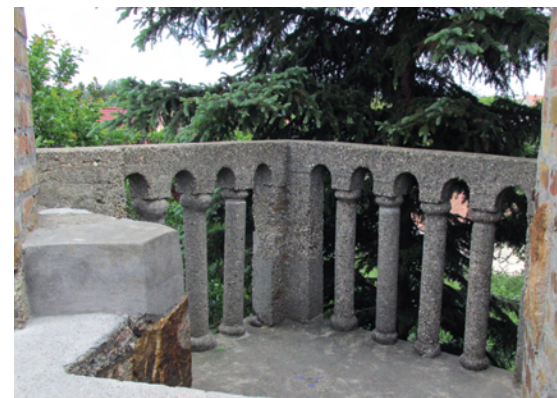
4. kép Minden kis helyet kihasználta az építő, hogy kedvenc anyagával, a betonnal valamilyen többletet hozzon létre. Ez a kis beton mellvéd részlet 80 éves
