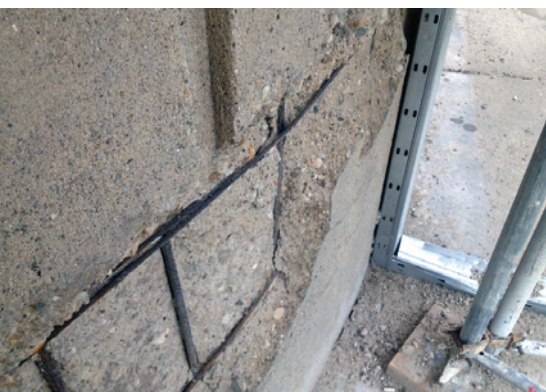
1. kép A vasbeton szerkezet állapota
