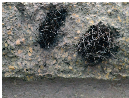
1. kép Szálak csomósodása beton elemében
