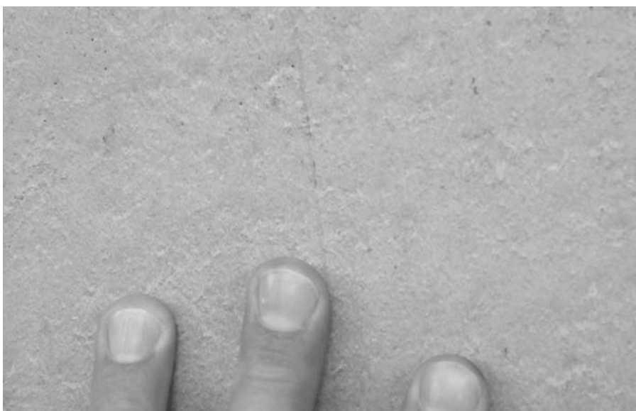
2. ábra Előregyártott betongerenda felülete Mapeplast FV adalékszerrel
