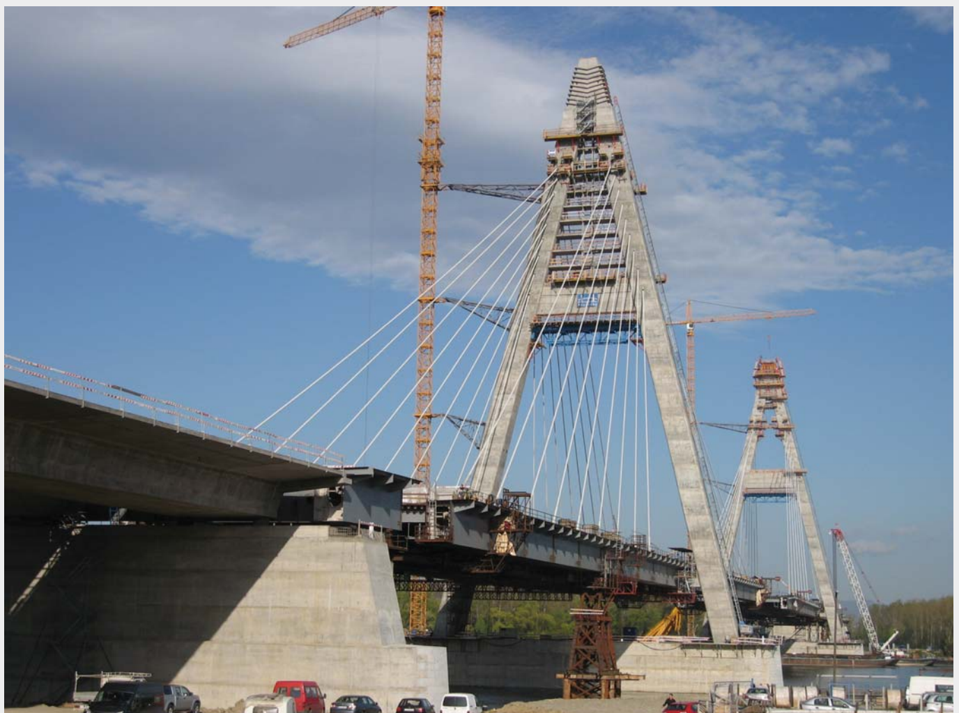
5. ábra A bal oldalon látható hídfőn csatlakozik nagy Duna-ág hídjára a bal parti vasbeton hídhoz
