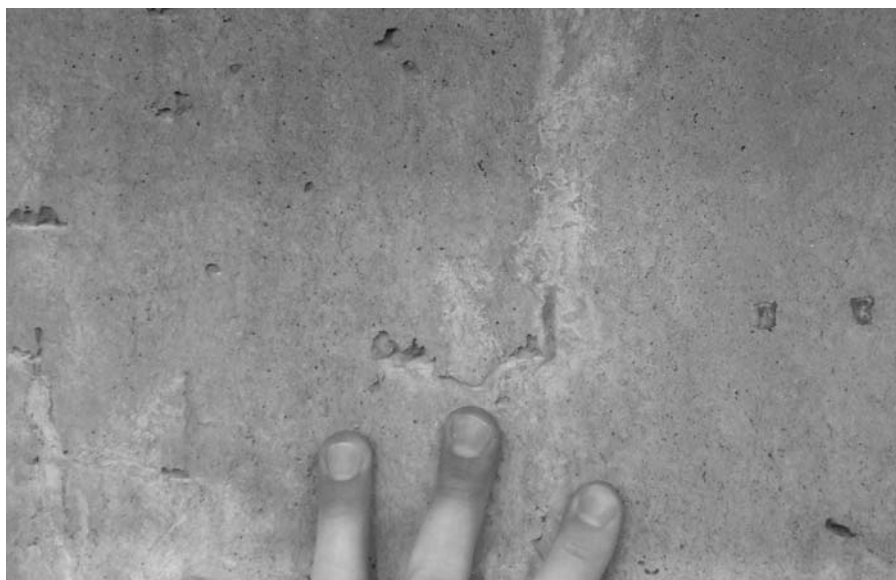
1. ábra Előregyártott betongerenda felülete Mapeplast FV adalékszer nélkül
