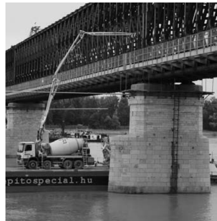
2. ábra Betonzás a VII. pillérnél a beúsztatott mixerkocsival
