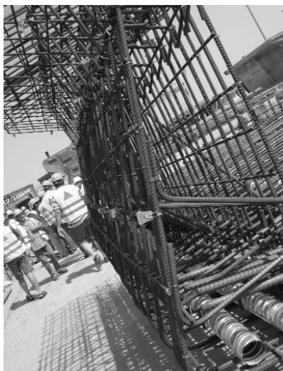
4. ábra Vasalási részlet távtartókkal és feszítőkábel üreggel
