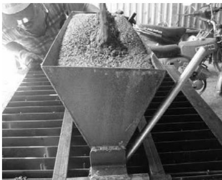
14. ábra A Hollandiába szállított, ~3000 db egyedi NSZ-NT vasbeton lap (C 55/67) készítése (selejtarány: 12/3000 db)
