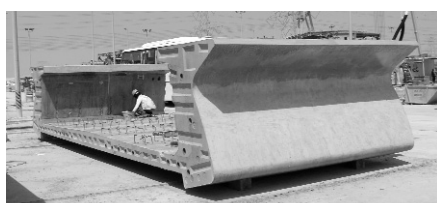
5. ábra Az elem kész, kisebb javítást igényel
