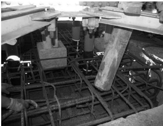
3. ábra Betonozási közelkép
