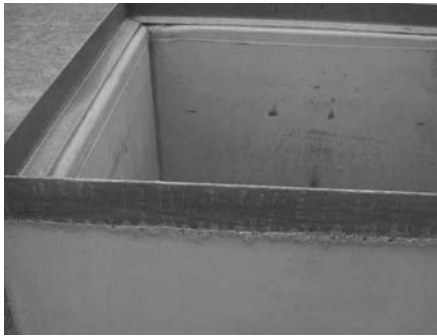
13. ábra Látható pórusoktól mentes, látszóbeton felület egy külön vízzáró adalékszer nélkül is XV3 vízzáróságú (vízbehatolás 3-10 mm között), C 55/67-re adódó szilárdsági jelű, gánti dolomitúzalékból készített vasbeton szerelőknánál (selejtarány: 1/500 db)
