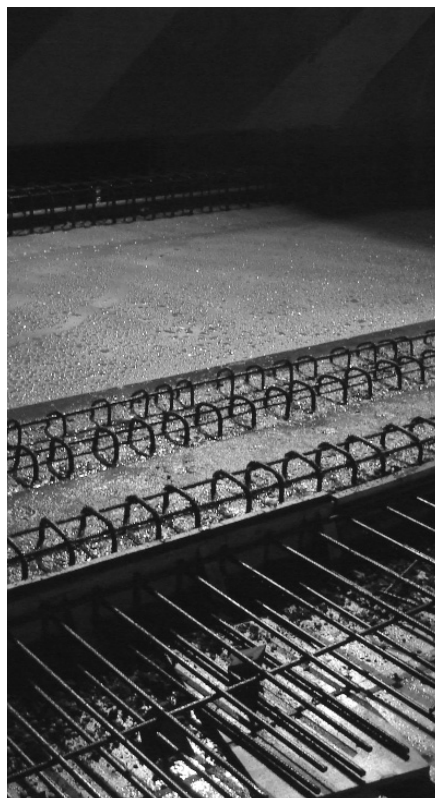
3. ábra A frissen elkészült pályalemez
