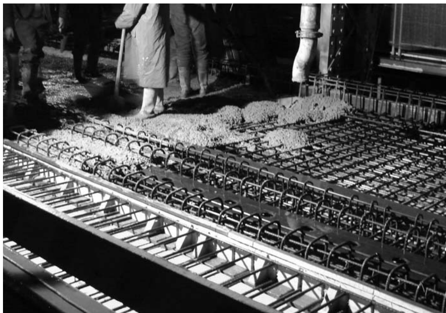
1. ábra A betonszivattyúból a vasalás közé kerül a beton
