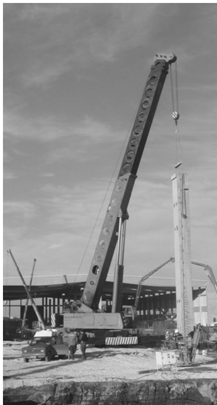
3. ábra A 16 m-es pillér beemelése Lapovoban
