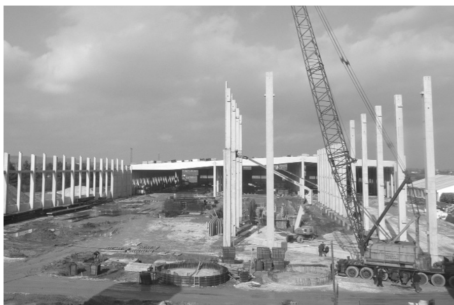
6. ábra Indulbat a 48 m fesztávú fatartók szerelése
