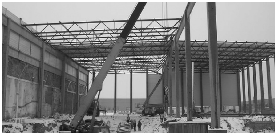
1. ábra Novovolinszk: vasbeton pillérek és főtartók, acél rácsos fióktartók
