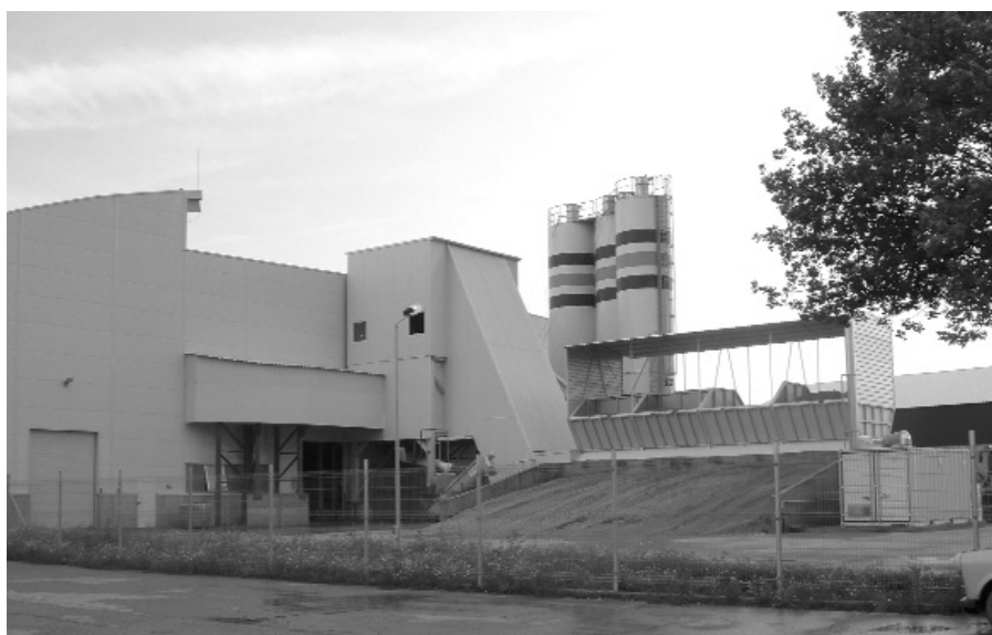
1. ábra Üzemi épület, adalékanyag tárolás, és a cementsilók
