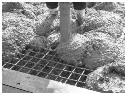
1. ábra A transzportbeton értékesítésének alapja a frissbeton mennyisége
