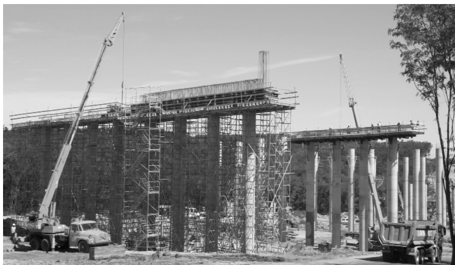
1. ábra A 64-es völgyhídnál már elkészültek a pillérek
