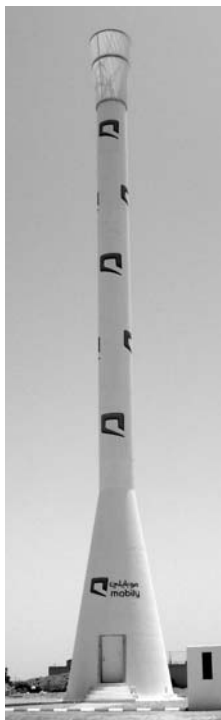
1. ábra Egy 40 m magas torony, amelynek előregyártott elemei legalább f_{cm, cube} = 80 \text{ N/mm}^2 átlagos nyomószilárdságú betonból készülnek (magyar termék)
