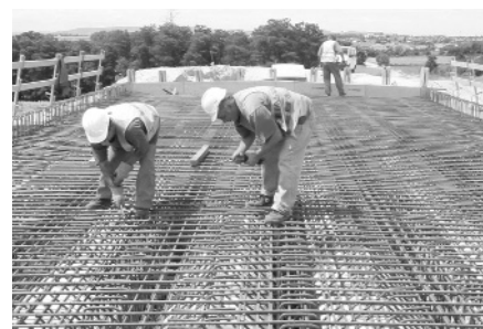
2. ábra Aluljáró vasszerelése
