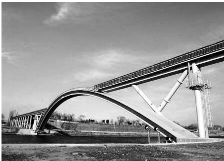
3. ábra Az 1998-ban, Ductal® típusú ultra nagy szilárdságú finombetonból épült Peace-gyalogoshíd Szoulban. Fesztávolsága 120 m, magassága 15 m, pályalemeze 4,3 m széles és 3 cm vastag, keresztiszelvénye 1,1 m magas.
