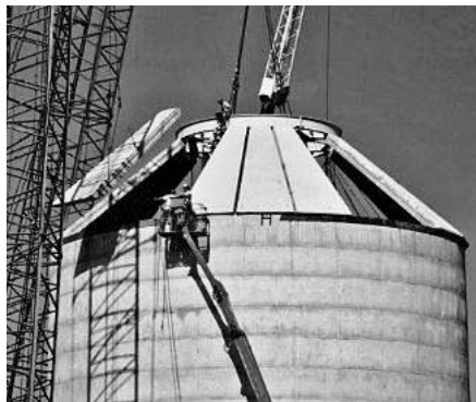
4. ábra Klinker siló ultra nagy szilárdságú betonból készült tetőpanele. Helyszín: USA, Illinois szövetségi állam, Joppa. Épült 2001-ben.
