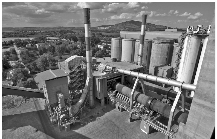
1. ábra A gyár látképe a magasból. A nagy átmérőjű, fekvő hengerek közül a bal oldali az új kemence
