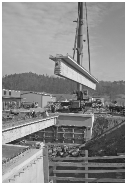
1. ábra A vasbeton hídgerenda gyártásánál a legkorszerűbb adalékszereket használták
