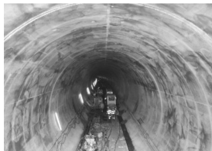
2. ábra Alagút belső beton felülete
