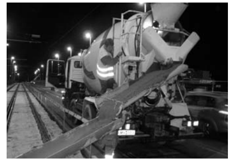
15. ábra A könnyűbeton sínszálak közé juttatása
