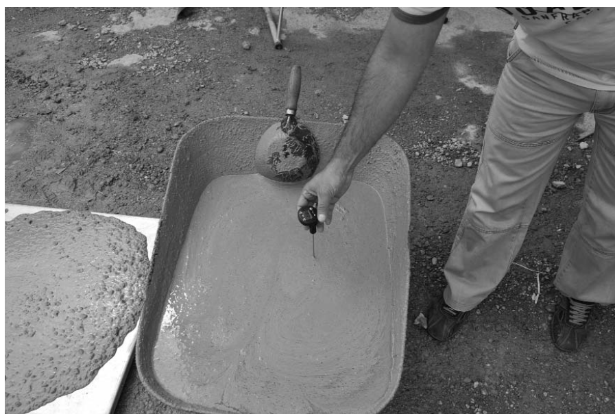
3. ábra A beton hőmérsékletének ellenőrzése
