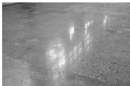
4. ábra A csongrádi üzemcsarnok felújított padlója
