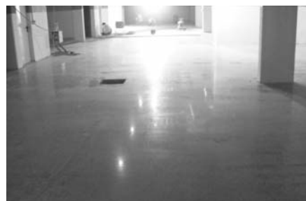
6. ábra Mélygarázs felújított padlója
