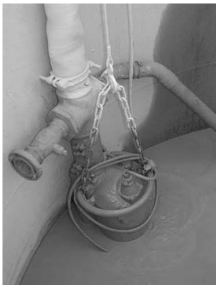
3. ábra Szuszpenzió szivattyúzása
