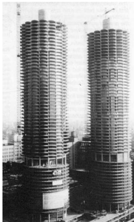
3. ábra Marina City Towers (Chicago) – a két 180 m magas torony földlemezéibe 1962-ben 19 000 m 3 1680 kg/m 3 testsűrűségű könnyűbetont építettek be (fib 2000)
