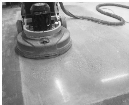
2. ábra Átváltozik a betonfelület
