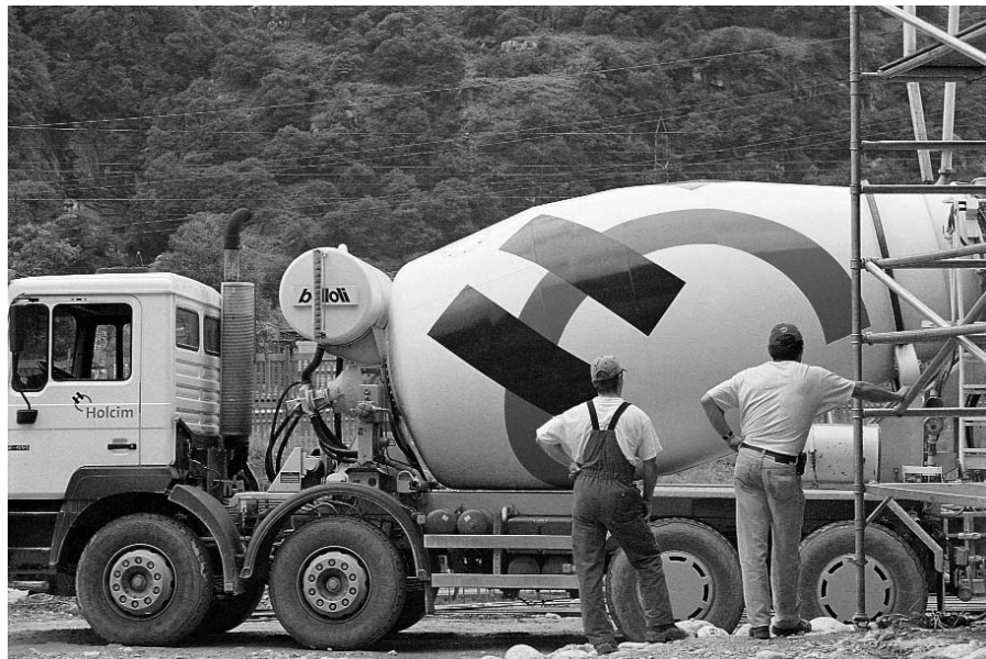
1. ábra Ne álljon a beton a mixerkeocsiban
