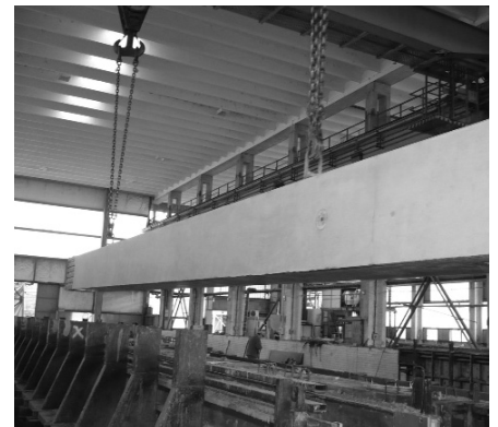
2. ábra Pillér CEM I 42,5 N cementtel készült betonból
