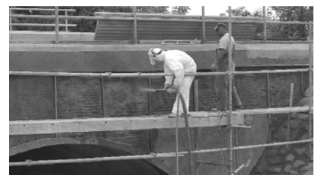
12. ábra Híd szerkezetének megerősítése lőttbetonnal
