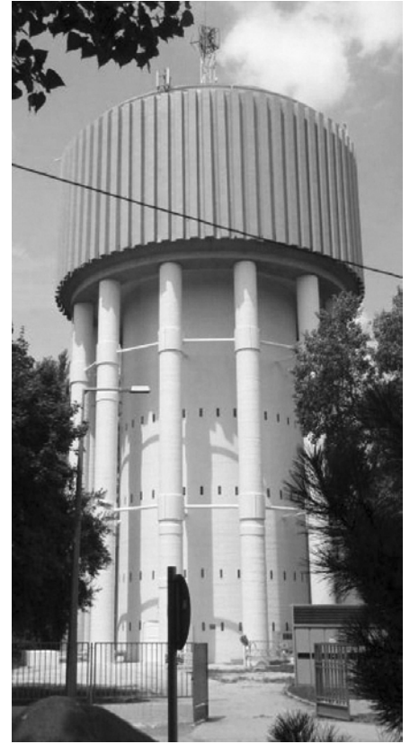
5. ábra A felújított víztorony
