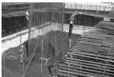
13. ábra Cementklinker homogenizáló nagytömegű alaptestjének betonozása
