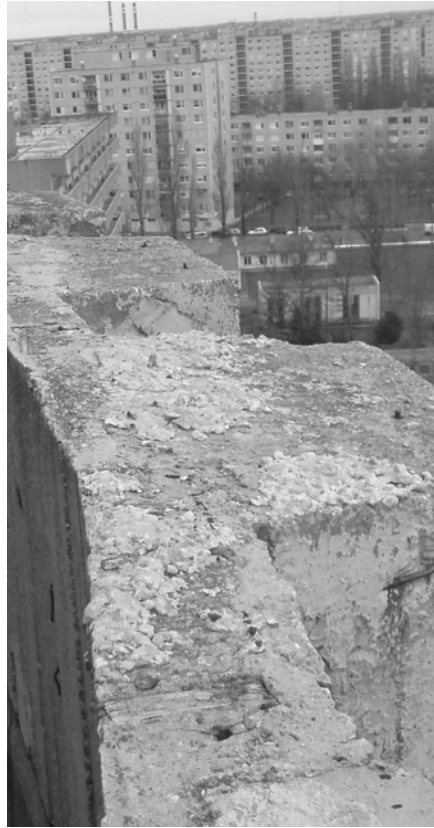
4. ábra Korrózió a víztorony betonján
