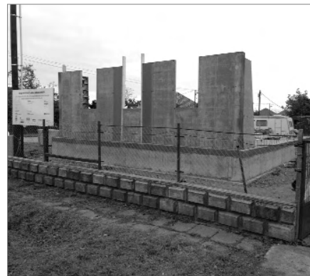
2. ábra A vasbeton falak kiszaluzás után
