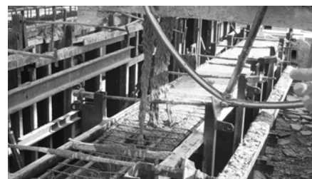
10. ábra Vasbeton áthidaló gerendák gyártása öntömörödő betonnal
