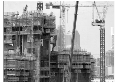
3. ábra A Burj Dubai Tower építése nagy teljesítőképességű betonból
