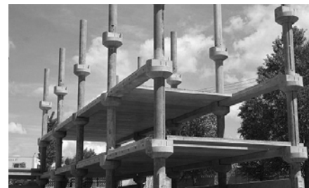
15. ábra Vázszerkezet konzolos pörgetett oszlopokkal
