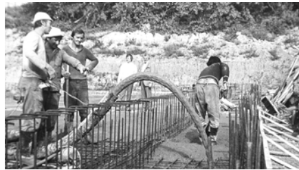
6. ábra Úszómedence alaplemeznének készítése vízzáró betonnal
