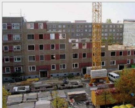
2. ábra Többszemeletes panel lakóépület bontása (forrás: BTU)
