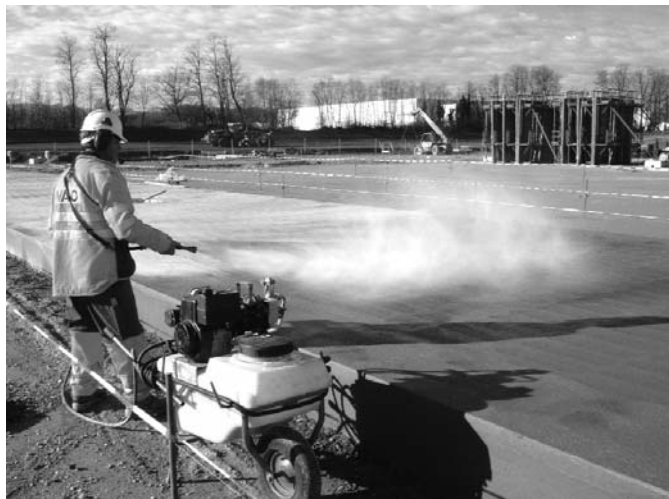
3. ábra Betonfelület utókezelése
