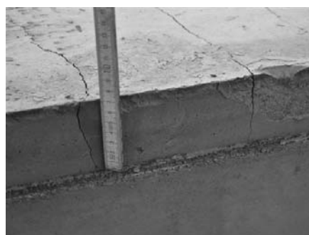
1. ábra Plasztikus zsugorodási repedések A burkolati beton plasztikus zsugorodásának oka a korai kiszáradás, vagyis a nem megfelelő felületi védelem (utókezelés hiánya).
