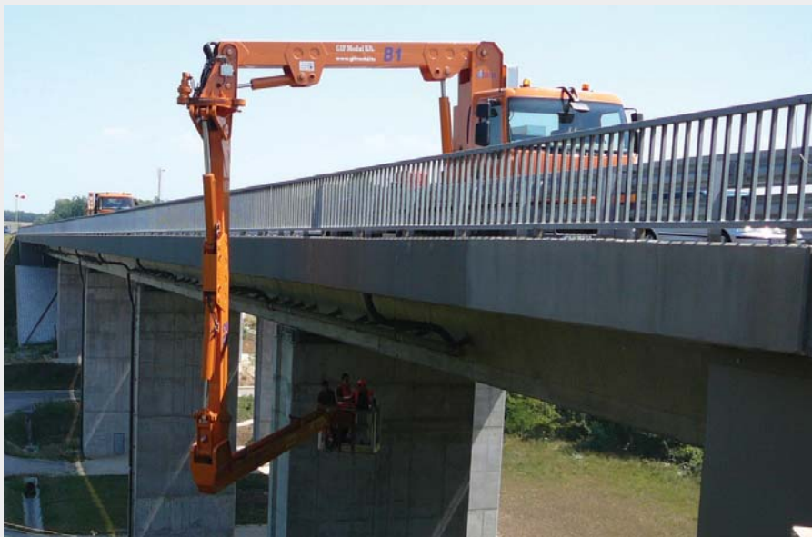
2. ábra Ez a speciális hídvizsgáló kocsí segíti a felszerkezet külső betonfelületének a vizsgálatát a völgyhídon is
