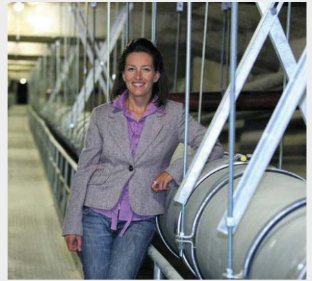
4. ábra A szekrénytartós felszerkezet belsejében helyezték el a csapadékvíz elvezető csövet, a kezelőjárdát.
