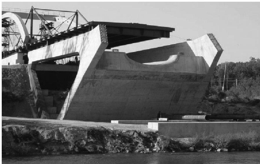
1. ábra Galgamácsai híd (öntömörödő betonból)
