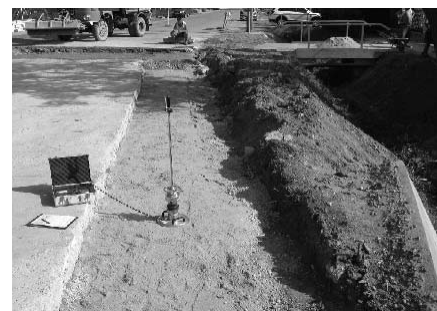
2. ábra A megsüllyedt talaj cseréje után a vízvezeték feletti Ckt visszatöltés
