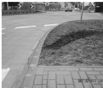
6. ábra A szegélyre történt rábajtás nyomai
