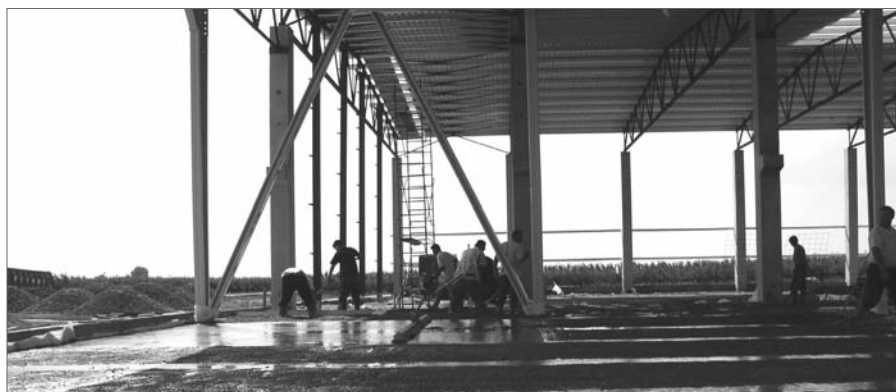
1. ábra Ipari padlót készíteni nyitott tető alatt, oldalfalak nélkül, a napsütés, az esővesztés, a huzat miatt - biztos kudarc
