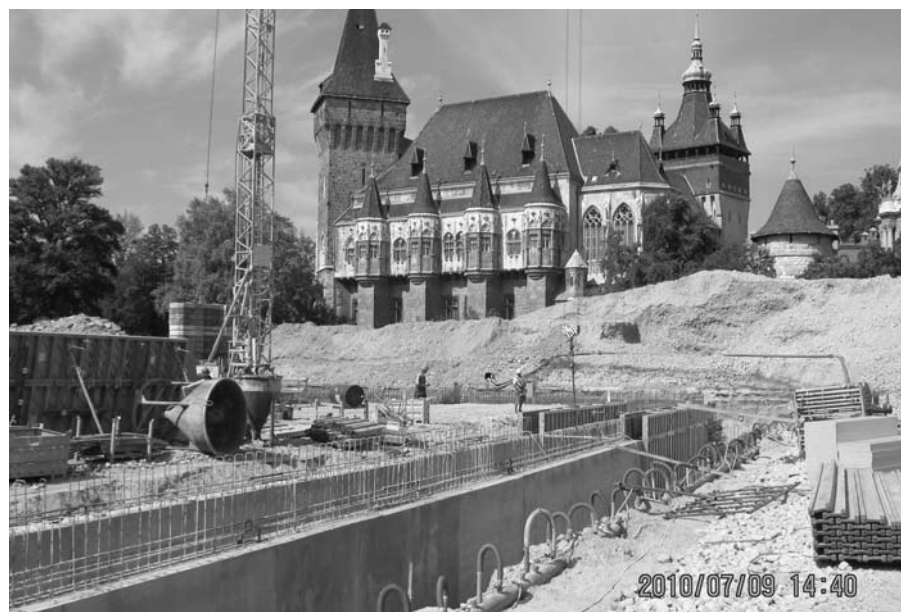
1. ábra Az építési helyszín
