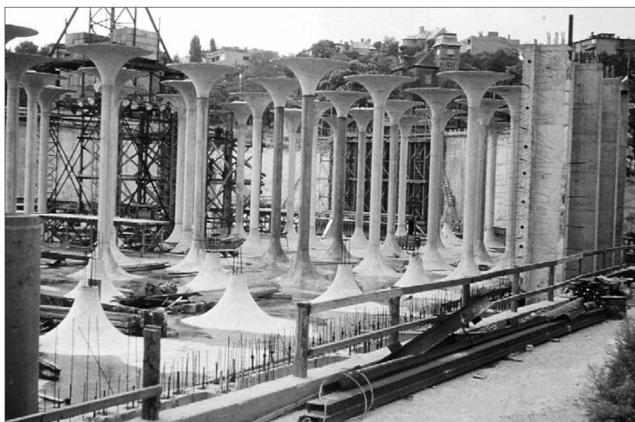
1. ábra Gellérthegy, Sánc utcai víztározó egyik medencéje építés közben. A fényképet Mábr Géza készítette 1977-ben
