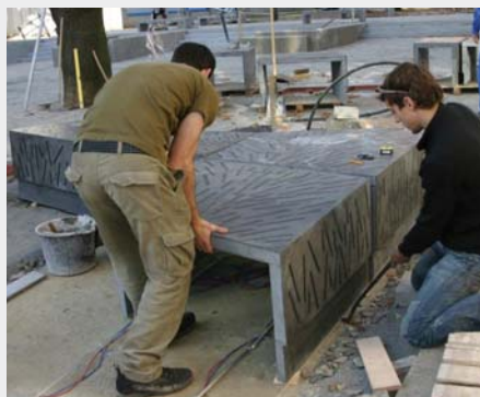
1. ábra Az előregyártott elemek illesztése
