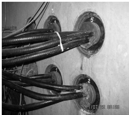
3. ábra Vezetékek csatlakoznak a falhoz
