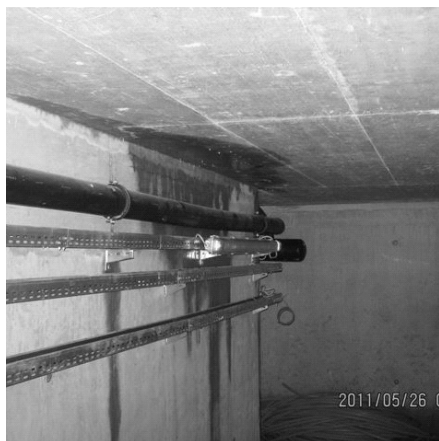
4. ábra Vízbeszivárgás nyoma az alagútban. A későbbiekben kiszáradt, mivel a kialakuló adalékszer kristályok tömítették a víz útját.
