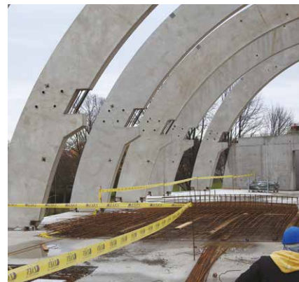
Az íves pillérek és a monolit födém csatlakozását szolgáló kirekesztett vasalás
