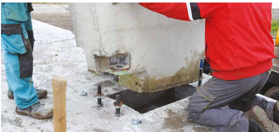
A két részből felépülő íves előregyártott pillérek csavaros kapcsolata
