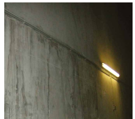
1. kép: az egyébként vízzáró betonszerkezet a munkahézagoknál átengedte a vizet.
