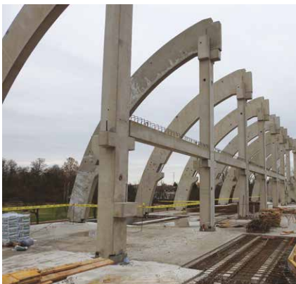
Az előregyártott vasbeton szerkezet a felülbordás közbenső födémrészsel.
