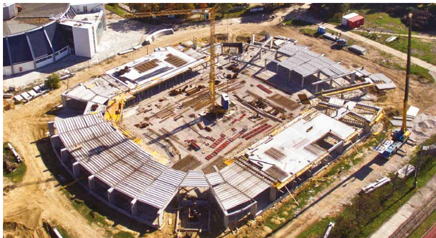
A közbenső födém szint előregyártott felülbordás pallóinak elhelyezése és a felbetonréteg részbeni elkészülte
