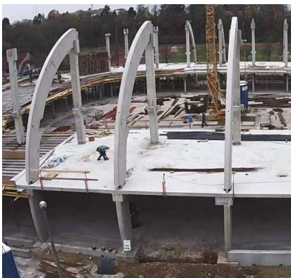
A monolit felbeton elkészülte után emelhetők be az íves pillérek felső elemei
