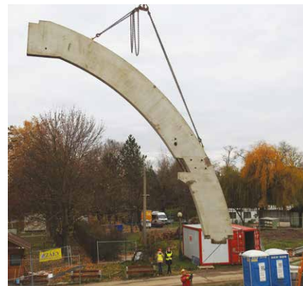
Az íves pillérek tervezésekor figyelembe veendő az összes építési állapot és ezeknek az állapotoknak a kritériumai
