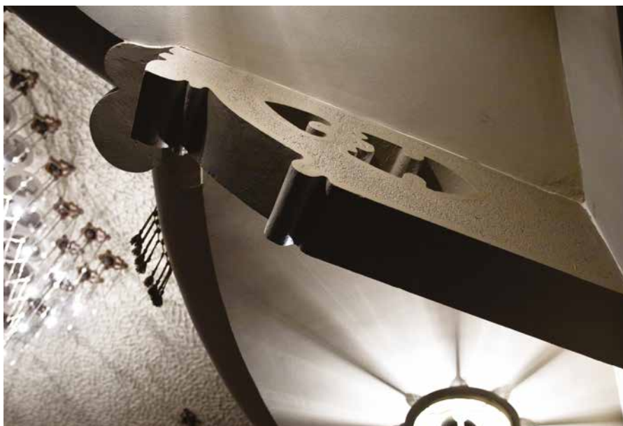
Erkélytartó vasbeton konzol a soproni színházban / Fotó: Gyukics Péter
